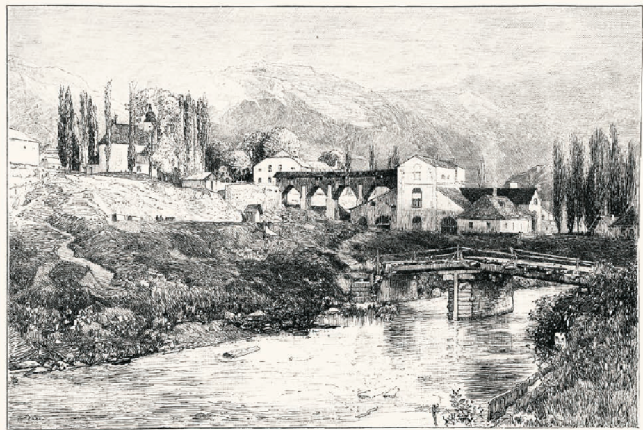
Abb. 64: Jakobeny an der Goldenen Bistritza . Illustration aus dem Kronprinzenwerk mit Teilen des Hüttenwerkes und der katholischen Kirche am linken Flussufer unweit der Straße. 53
