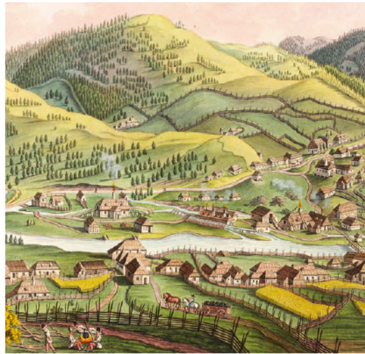
Abb. 61: Ansicht Der Eisenberg und Hüttenwerke zu Jakobeny in der Bukkowina nach 1810, gewidmet Kaiser Franz I. Der Ausschnitt zeigt einen Teil der Manzschen Anlagen (Öfen, Schmieden, Pochwerke) zur Erzverarbeitung. © ÖNB PK 3.003 Blatt 641 34
