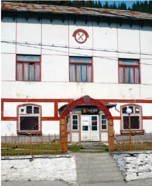
Abb. 70: Noroc Bun! ( Glück Auf! ), so der Bergarbeiterspruch über dem Hauseingang. Das ehemalige Deutsche Haus – unmittelbar an der Hauptstraße gelegen – diente bis zur Umsiedlung ins Deutsche Reich 1940 der bevölkerungsstärksten Gruppe des Ortes als Kultur- und Vereinszentrum, danach war es bis 1991 Treffpunkt der Bergarbeiter. © K. Scharr, April 2013.
