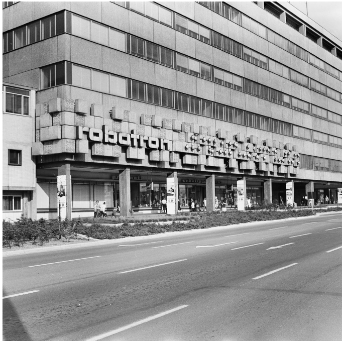
Abbildung 145. Kollektiv Roland Hühnerfürst, ehemaliges Robotron-Bürogebäude und Forschungszentrum an der Ernst-Thälmann-Straße, Chemnitz, plastische Fassadenelemente von Helmut Humann, Aufnahme 1973, Fotograf: Hebert Kapf.
