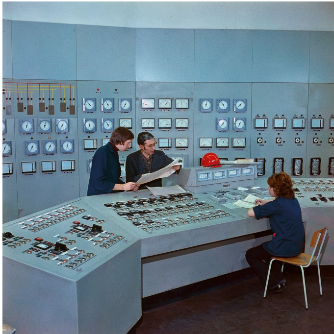
Abbildung 22. Chemiewerk Leuna II bei Halle an der Saale, Meßwarte, Aufnahme 1973, Fotograf: Peter Straube
