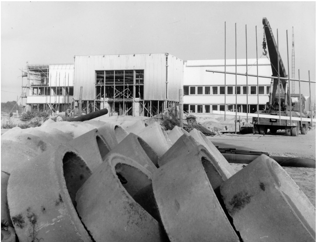
Abbildung 27. Akademie der Marxistisch-Leninistischen Organisationswissenschaft, Berlin-Wuhlheide, Zustand der Baustelle im Sommer 1969, Blick auf den Haupteingang mit dem Foyer, für das Josep Renaus Wandbild entworfen wurde, Fotografie.
