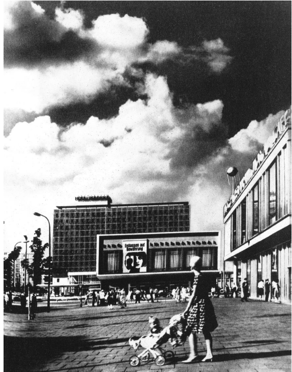
Abbildung 106. Dieter Urbach, Ecke Karl-Marx-Allee / Ecke Schillingstraße, Berlin, Fotomontage, 1. Preis beim Wettbewerb »Baufoto 1965«, aus: Deutsche Architektur , 1966.
