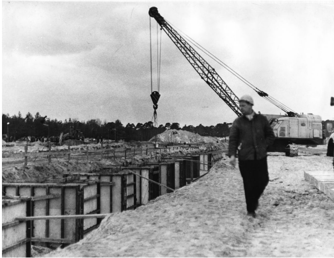
Abbildung 159. Richard Paulick, AMLO, Berlin-Wuhlheide, Zustand der Baustelle im Winter 1968/69, Fotografie, Architekturmuseum der TU München.
