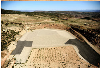
Uravan Disposal Cell, CO.
