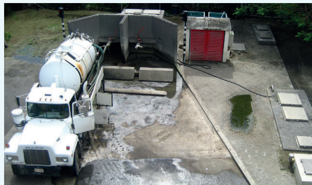
Figure 9.10 : Dépotage de boues de vidange à la station d'épuration d'Illidge Road, au niveau du bassin tampon.
