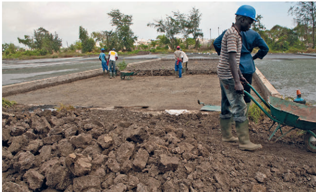
Figure 7.5 : Curage des boues de lits non-plantés à la station de traitement de Cambérène, Dakar, Sénégal (photo : Linda Strande).
