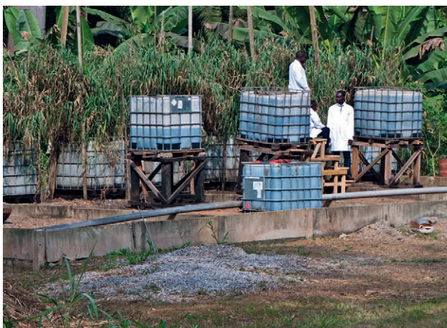
Figure 8.1 : Pilote de lits de séchage plantés pour le traitement des boues de vidange de l'université de Yaoundé (photo : Linda Strande).
