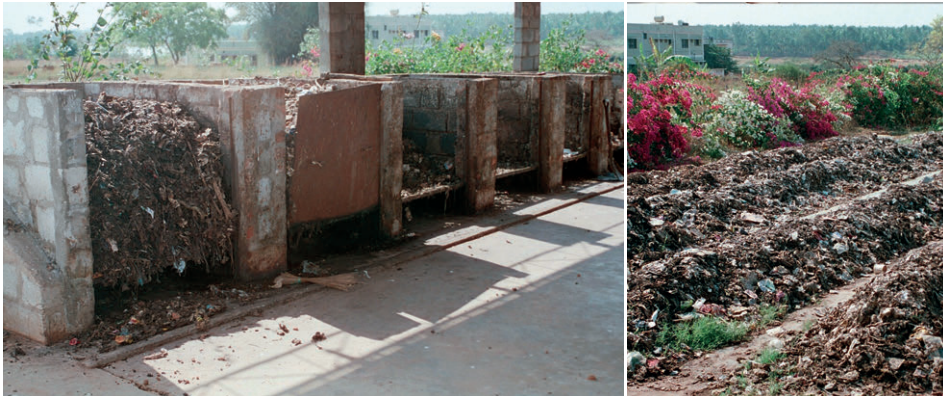
Figure 3.11 : Installation de cocompostage pilote avec des boues de vidange et des déchets municipaux à Bangalore, en Inde (photo : Chris Zurbrügg).
