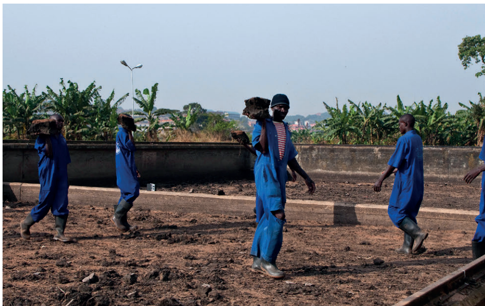
Figure 11.7 : Curage des boues séchées d'un lit de séchage non-planté à la station de traitement de Bugolobi à Kampala, Ouganda (photo : Linda Strande).
