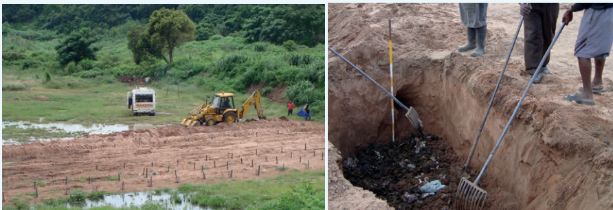
Figure 5.3 : Site expérimental d'enfouissement en tranchées profondes d'Umlazi. À droite : enfouissement des boues de latrines dans des tranchées d'un mètre de profondeur. À gauche : vue générale des plantations d'arbres sur les tranchées remplies. Les puits d'eau potable étaient répertoriés et les niveaux de nutriments, de matières organiques et d'agents pathogènes surveillés (photos : Jay Bhagwan, Water Research Council, Afrique du Sud).
