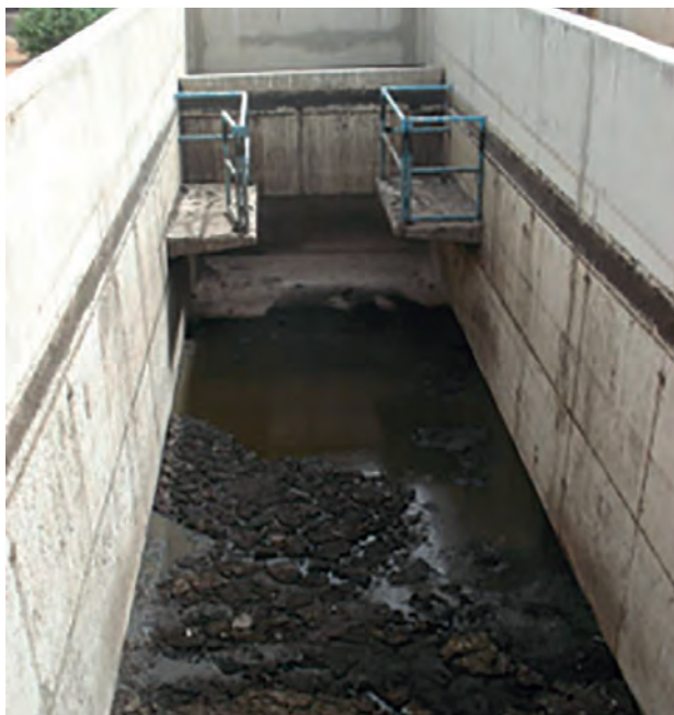
Figura 6.6 Esta capa de nata se ha quedado en el fondo de un tanque de sedimentación y espesamiento, luego del bombeo de la fracción líquida y los lodos espesados, en la ETLF Rufisque, Senegal (foto: SANDEC).
