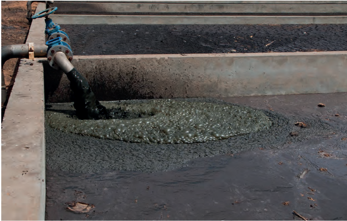
Figura 7.4 Carga de lodos sobre los lechos de secado en la Estación de Tratamiento de Lodos Fecales Niayes, en Dakar, Senegal (foto: Linda Strande).
