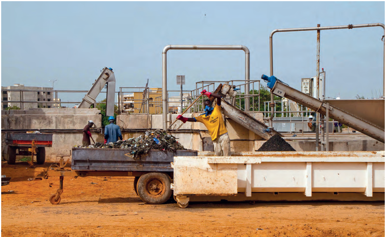
Figura 11.1 Limpieza de los tamices en una estación de tratamiento de lodos fecales en Dakar, Senegal; esta actividad es imprescindible en cada turno para mantener el sistema operativo (foto: Linda Strande).
