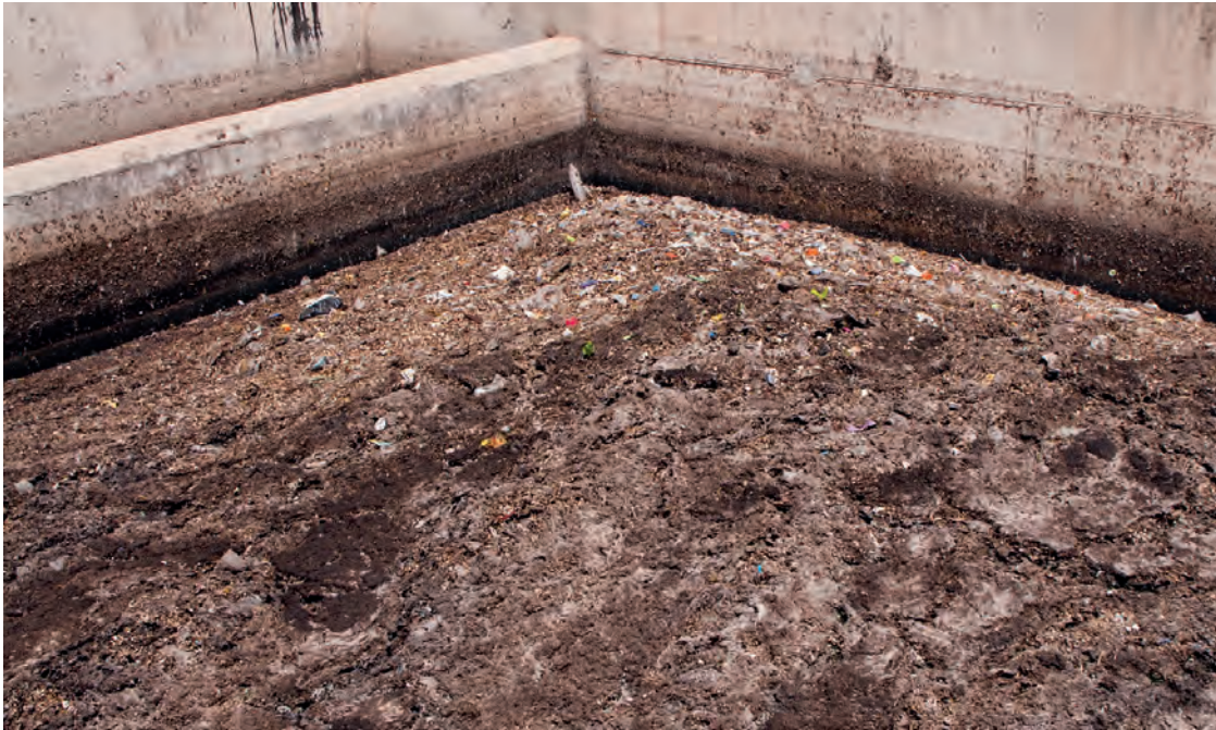
Figura 3.2 Tanque de sedimentación en la Estación de Tratamiento de Lodos Fecales Niayes, en Dakar, Senegal (foto: Linda Strande).
