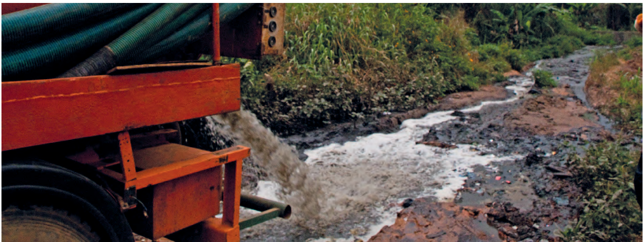
Figura 12.3 Descarga ilegal de lodos fecales directamente al ambiente, en Yaoundé, Camerún (foto: Linda Strande).
