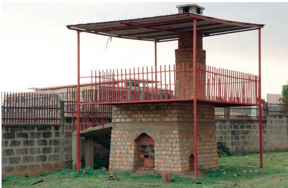
Figura 18.6 Horno en tamaño piloto del proyecto FaME (Emprendimientos para Manejo Fecal) para la co-combustión de lodos fecales en la producción de ladrillos en Kampala, Uganda (foto: Pitman Ian Tushemezibwe)
