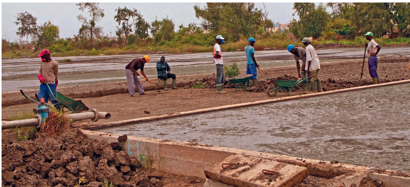
Figura 12.2 Extracción de lodos fecales de un lecho de secado sin plantas para luego aplicarse en la agricultura como una enmienda del suelo (foto: Linda Strande).
