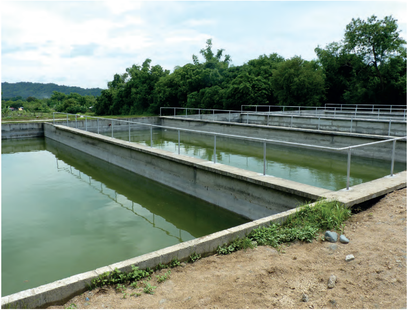
Figura 11.8 Puesta en marcha de un sistema de lagunas para lodos fecales en San Fernando, Filipinas. En este caso, las lagunas fueron inoculadas con lodos activados de una estación de tratamiento cercana. (Foto: David M. Robbins).
