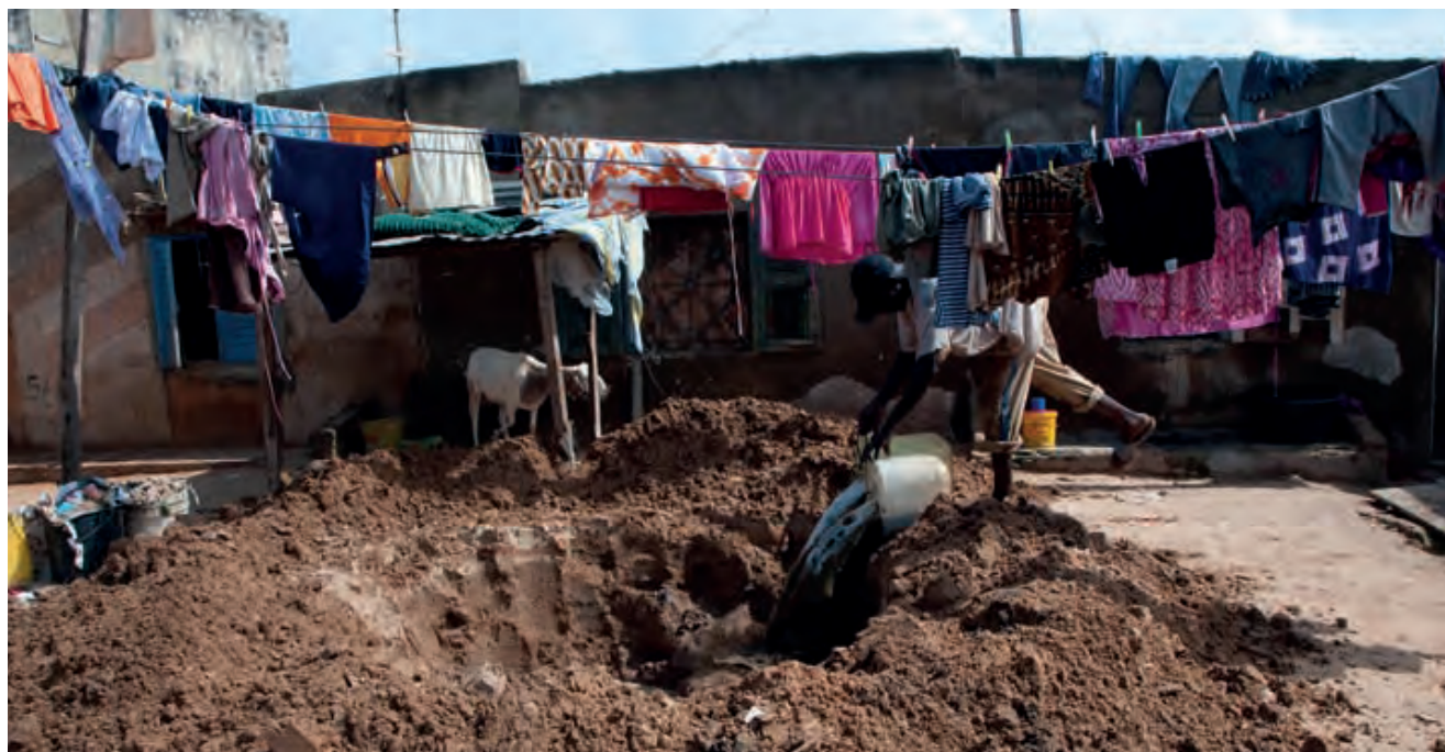
Figura 14.9 Vaciado manual de lodos fecales, enterrándose en el mismo patio de la casa (foto: Linda Strande).
