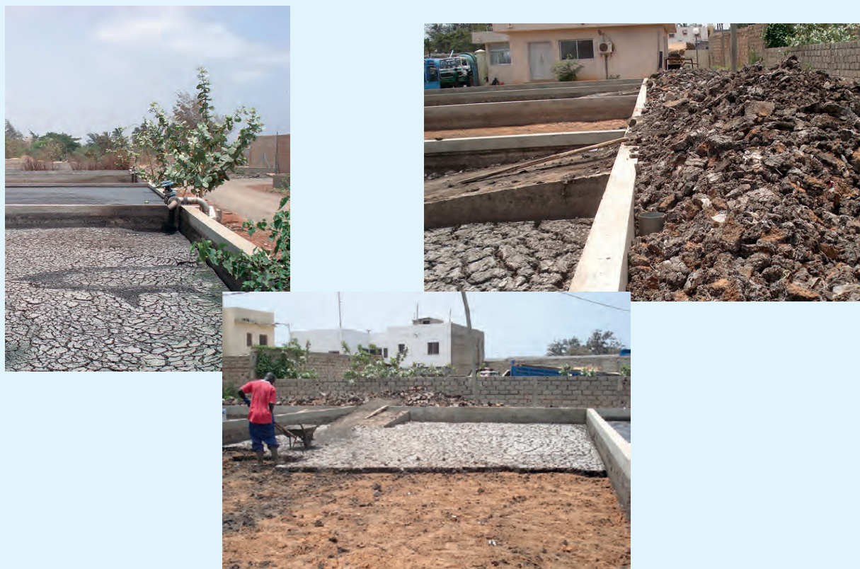
Figura 7.6 Lechos de secado sin plantas, con la acumulación y extracción de los lodos (der.), en la Estación de Tratamiento de Lodos Fecales Cambérène, en Dakar, Senegal (fotos: Pierre-Henri Dodane).
