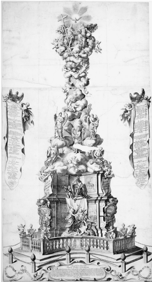
Abbildung 1: Bartholomäus Kilian nach Lodovico Ottavio Burnacini, Die Pestsäule in Wien, Kupferstich, 1692.
