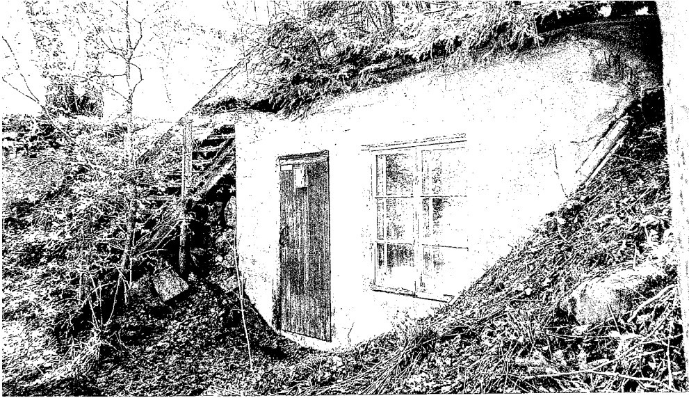
Tulenheimon vedenottamorakennus Ukkijärven rannalla. Kunnan pohjavedenottamo rakennettiin vuonna 1954. (Juuti)
