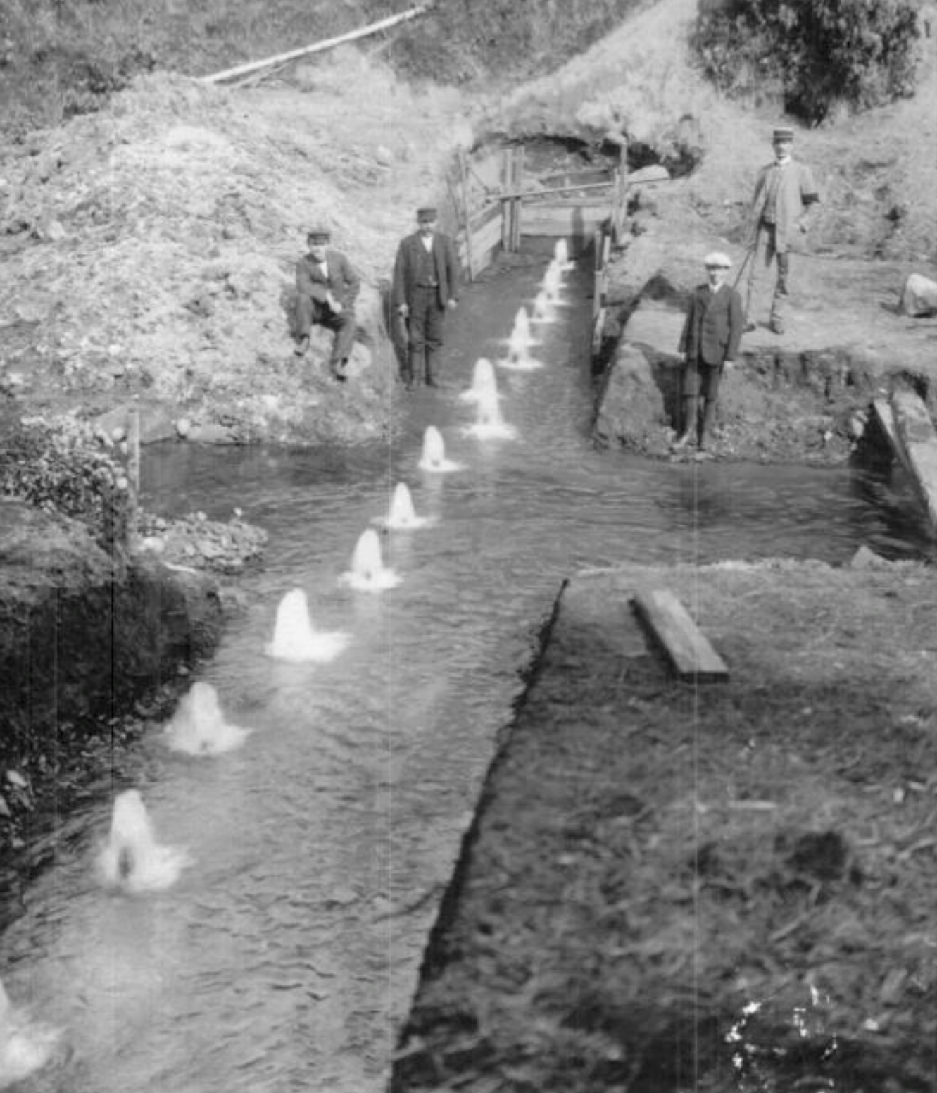
Pohjavesitutkimus käynnissä vuonna 1916 Vuohenojalla. (Tampereen Museoiden kuva-arkisto)
