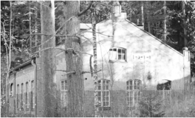
Ahveniston vesilaitos alkoi pumpata vettä vuonna 1910. (HS-Vesi 2010)
