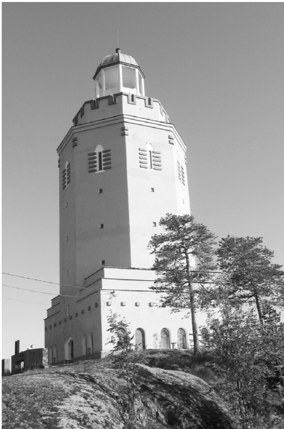
Kotkan vesitorni. (Juuti)
