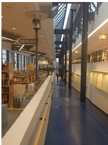
Kuva 2: Vihdin sininen muovimattoramppi kolisee kirjakärryjen alla.
