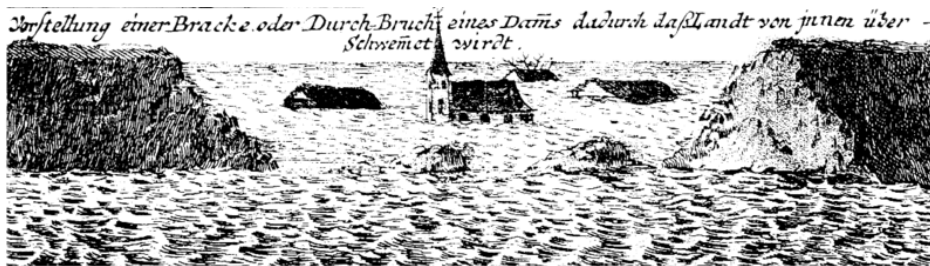
Abb. 3: Durchbruch eines Deiches
