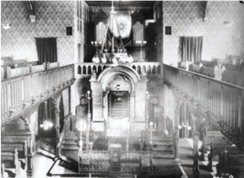
(Abb. 19: erweiterte Synagoge Innenraum, Ostansicht; unten Tora-Nische und Bima, oben Orgel)
