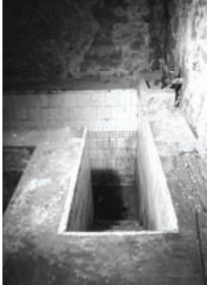
(Abb. 20a: Die Mikwe in der Roten Straße, Foto)
