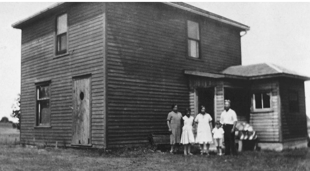
La maison en bois de deux étages d'Eliza Sero, à Eagle Hill, sur le territoire mohawk Tyendinaga, vers 1930.
