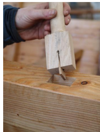
Abb. 6: Zum Einsetzen vorbereiteter Dollpflock mit Keil
