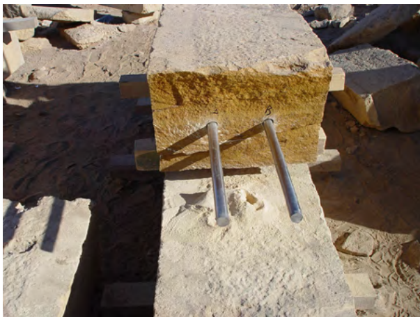
Figure 65. Le barre d'acciaio nei fori praticati nella sezione di uno dei due frammenti della trave principale posta sopra i due pilastri P6 e P10 e sopra il muro O della cella. (A. Paladino 2003 ©MAIRY)
