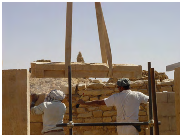
Figure 59. Movimentazione della cornice modanata orizzontale superiore - posta sotto l'architrave della porta della cella centrale del tempio - reintegrata nella parte mancante. (A. Paladino 2003 ©MAIRY).
