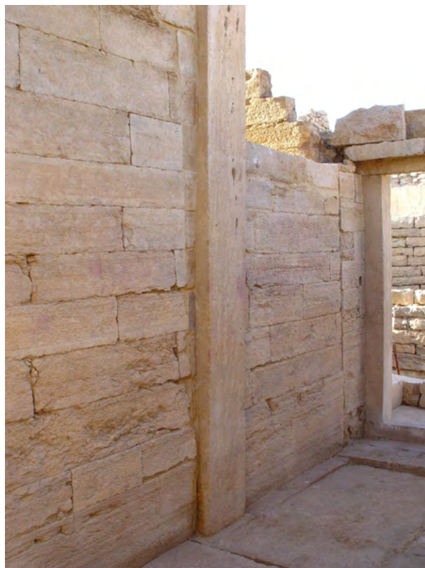
Figure 35. Il pilastro P1 rimesso in situ nel muro M1 dopo il restauro. (A. Paladino 2003 ©MAIRY)
