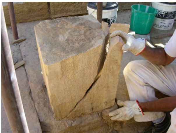
Figure 17. Frattura trasversale con distacco dello spigolo dell'angolo ovest della parte inferiore del pilastro P11. (A. Paladino 2003 ©MAIRY)
