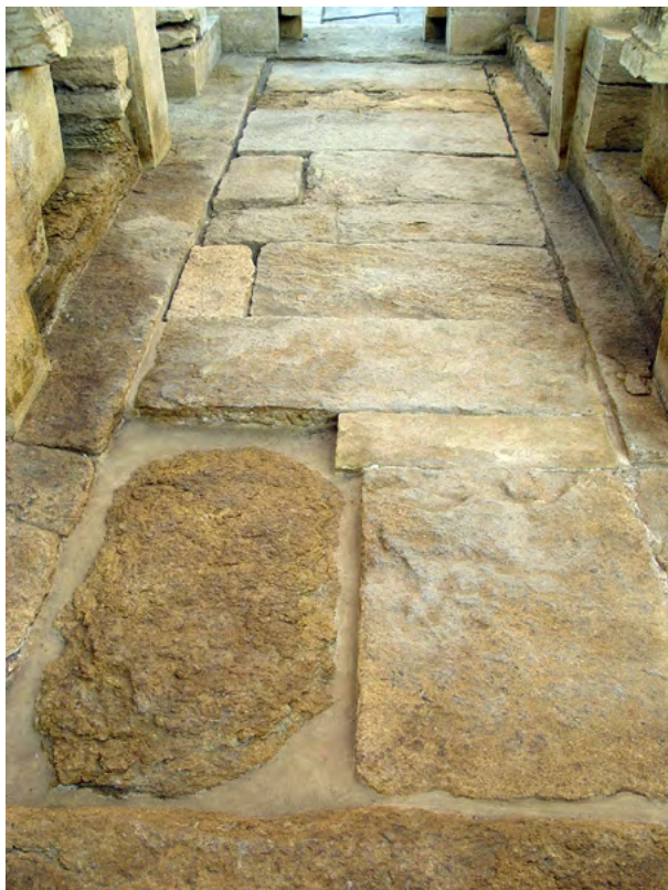
Figure 94. Il pavimento della navata centrale con le integrazioni delle lastre mancanti a fine restauro. (S.B. Scigliano 2003 ©MAIRY)
