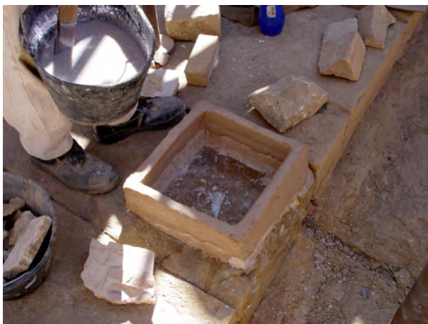
Figure 22. Sull'originaria base del P11 è stata costruita una base d'appoggio artificiale, alta 12 cm, per correggere la quota verticale del pilastro stesso. (A. Paladino 2003 ©MAIRY)
