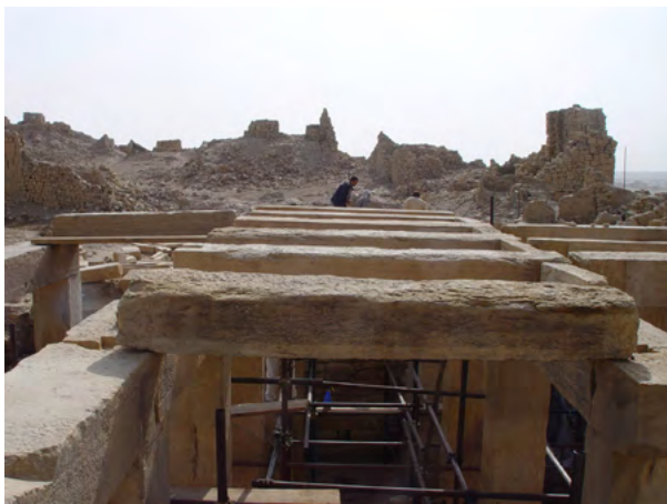
Figure 75. Infilata delle travi secondarie ricollocate sopra le travi primarie in corrispondenza della navata centrale del tempio. (A. Paladino 2003 ©MAIRY)
