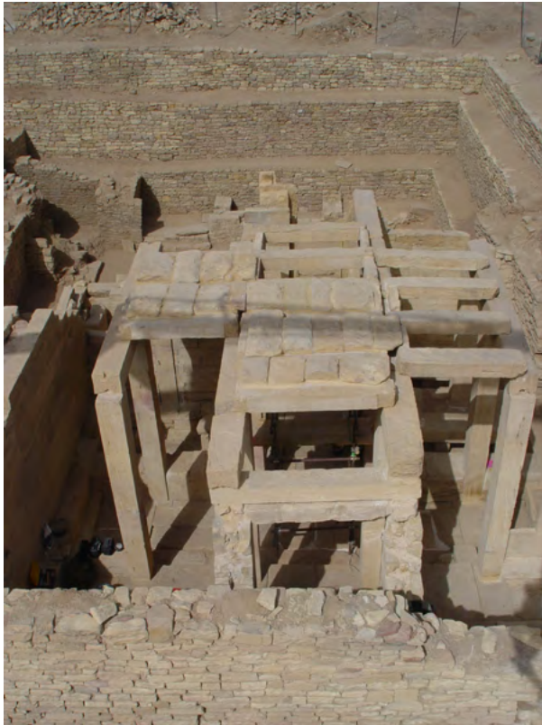
Figure 13. Vue axiale depuis le sud-ouest des ruines du temple de Nakraḥ montrant bien la destruction périphérique de la couverture. L'extrados des dalles de couvertures est très irrégulier et semble avoir été recouvert d'une épaisse couche d'enduit étanche. (A. de Maigret 2003-2004 ©MAIRY)
