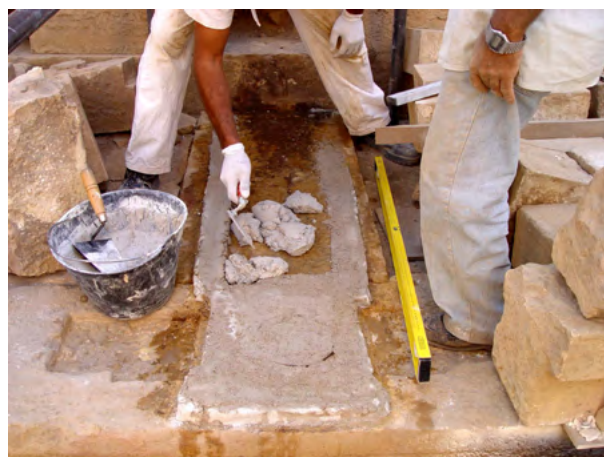
Figure 51. Fase di preparazione della base del muro occidentale, completamente smontato, della cella centrale del tempio. (A. Paladino 2003 ©MAIRY)
