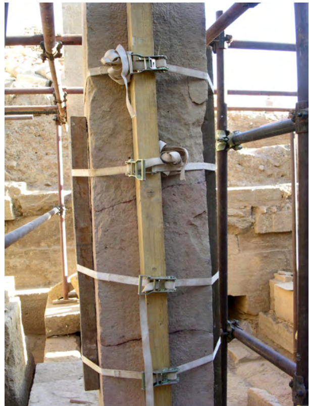
Figure 14. Le tre parti assemblate del P7 sono assicurate ai tubi metallici con cinghie di sicurezza, in posizione verticale. (A. Paladino 2003 ©MAIRY)
