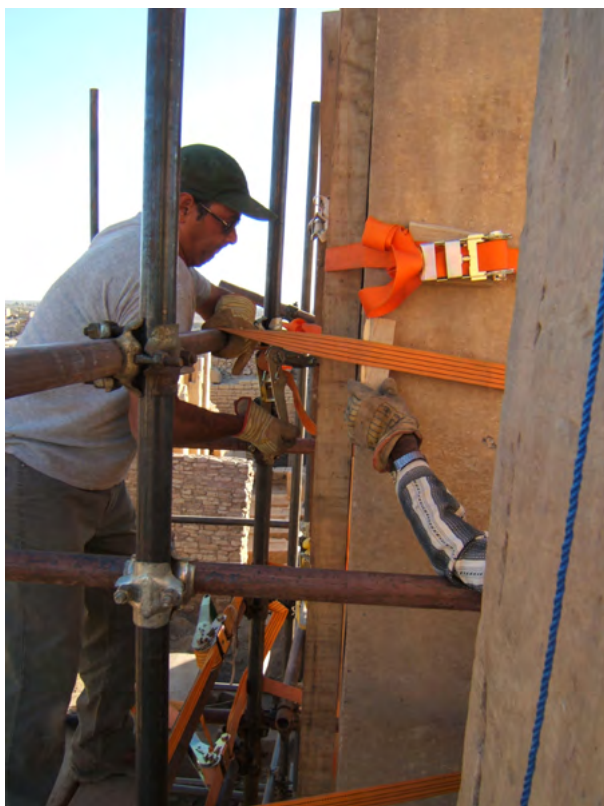
Figure 30. Il restauratore Saverio Scigliano mentre tira manualmente il tensore di una delle cinghie per raddrizzare uno dei pilastri del propileo. (A. Paladino 2006 ©MAIRY)
