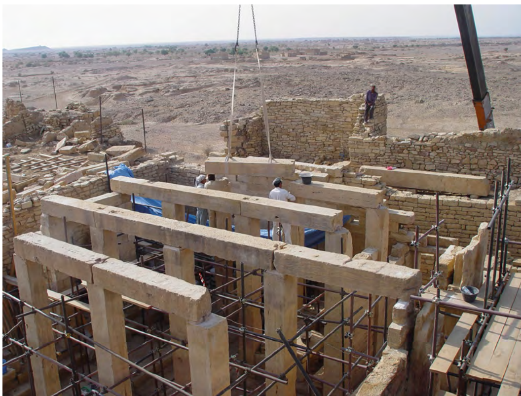
Figure 72. Veduta a volo d'uccello del posizionamento delle travi primarie sui pilastri. Una fila di tre travi si appoggia a partire dallo stipite orientale della porta del tempio, su P3, P7, P11 fino allo stipite orientale della porta della cella centrale (v. fig. 6). (A. Paladino 2003 ©MAIRY)
