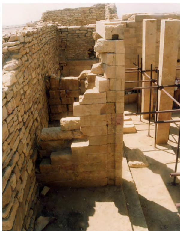
Figure 56. Il muro orientale della cella centrale del tempio, prima dell'intervento di restauro. (S.B. Scigliano 2003 ©MAIRY)
