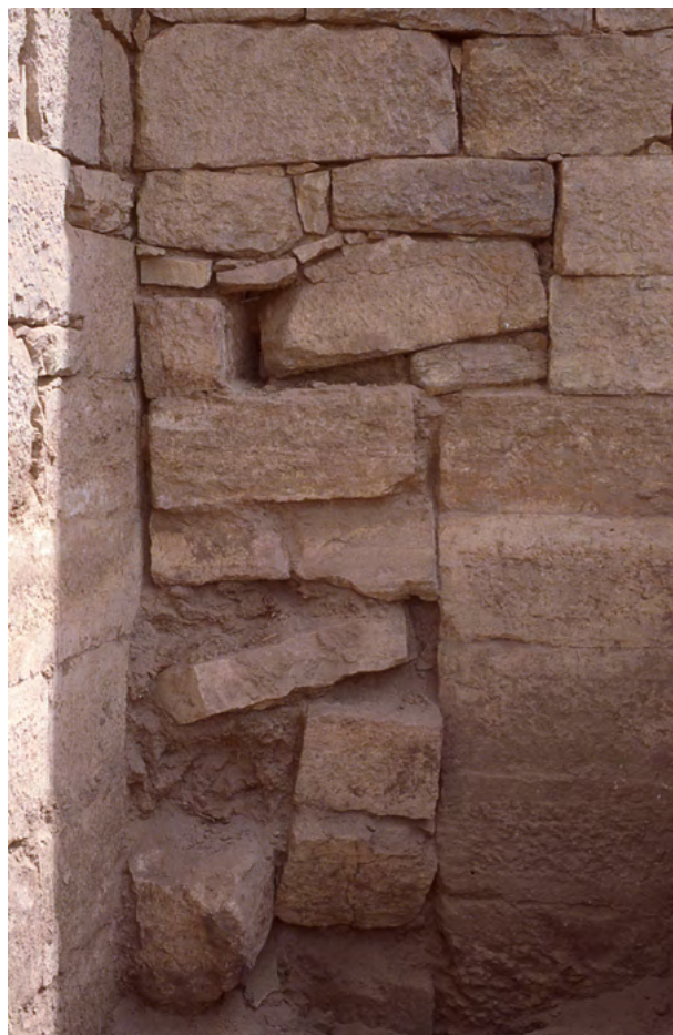
Figure 5. La porta M39P tamponata, vista dall'esterno. (A. de Maigret 1992 ©MAIRY)
