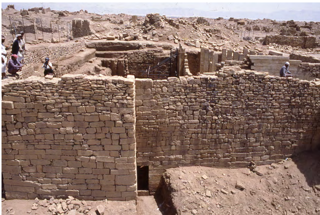
Figure 4. La posterla nel muro M39 (porta M39P) fotografata dal braccio della gru. (A. de Maigret 1992 ©MAIRY)
