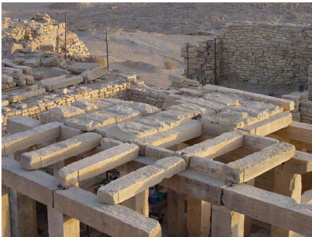
Figure 84. Veduta a volo d'uccello della copertura del tempio a fine restauro. (S.B. Scigliano 2003 ©MAIRY)
