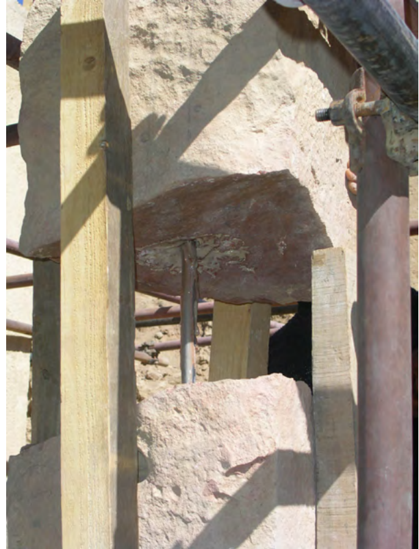
Figure 13. Assemblaggio delle varie sezioni del pilastro P7. (A. Paladino 2003 ©MAIRY)
