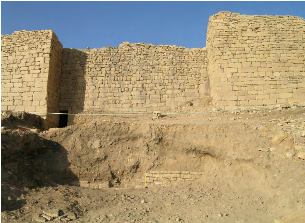
Figure 13. La sezione dello scavo davanti alla rientranza R44/45: in primo piano il lacerto di muro M50, messo in luce avvicinando il carro-gru alle mura. (A. de Maigret 2003 ©MAIRY)
