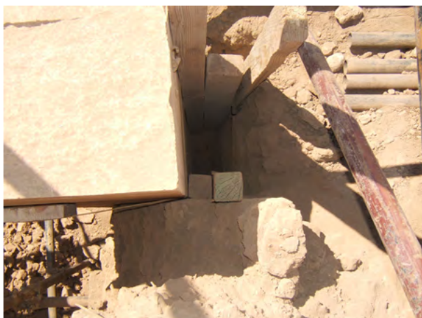
Figure 29. Durante la fase di spostamento per raddrizzare i pilastri del propileo, vengono inseriti cunei di legno nello spazio che si viene a creare nel lato N, tra il pilastro stesso e la sezione di terra. (S.B. Scigliano 2006 ©MAIRY)
