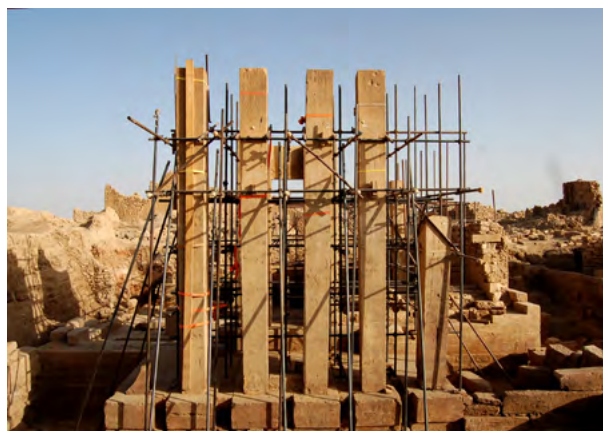
Figure 31. Vista frontale del propileo del tempio di 'Athtar dhu-Qabḏ: i pilastri sono assicurati all'impalcatura di tubi metallici attraverso spesse cinghie a cricchetto. (S.B. Scigliano 2006 ©MAIRY)
