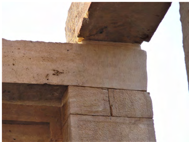
Figure 62. Dettaglio della porzione integrata dell'architrave della porta della cella centrale del tempio dopo il restauro. (S.B. Scigliano 2003 ©MAIRY)
