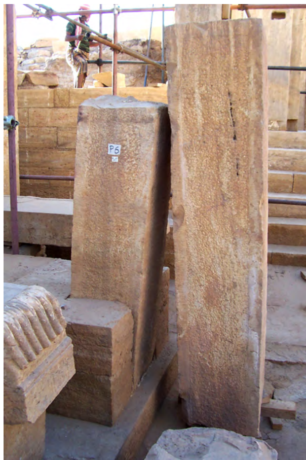
Figure 20. Il pilastro P6, inglobato per tre lati nella banchina, è incompleto e spezzato. La parte inferiore è inclinata verso N; la parte superiore, rinvenuta dislocata, vi è stata appoggiata contro. (S.B. Scigliano 2006 ©MAIRY)
