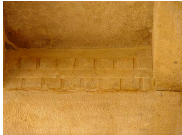
Figure 82. Dettaglio della stuccatura, di colore della pietra giallo-ocra, di una metopa a contatto con una lastra di copertura. (S.B. Scigliano 2003 ©MAIRY)
