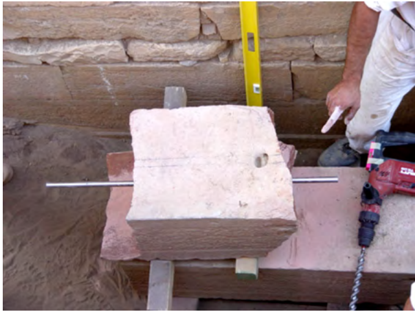
Figure 10. La barra d'acciaio attraversa tutta la sezione centrale del pilastro P7. (A. Paladino 2003 ©MAIRY)
