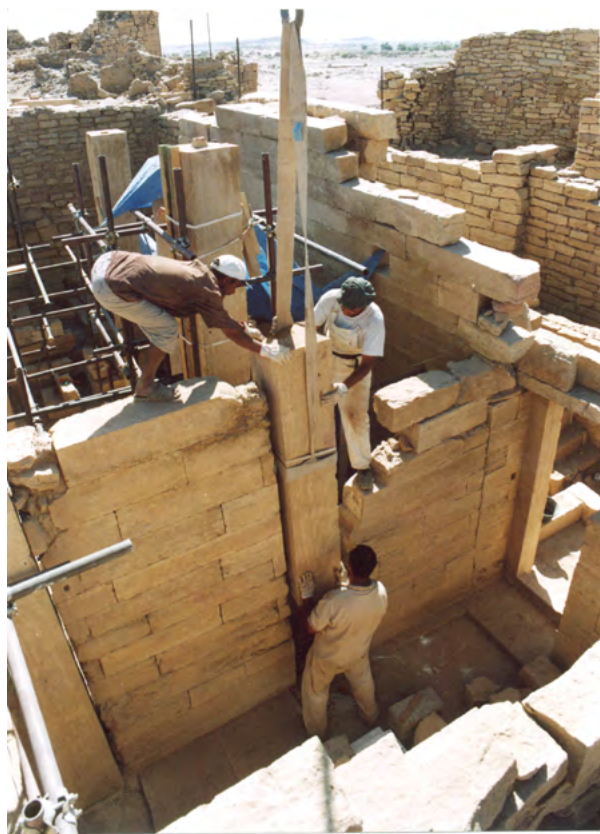
Figure 32. Rimozione della porzione superiore del pilastro P1 'sfilandola' dal M.1 (A. Paladino 2003 ©MAIRY)
