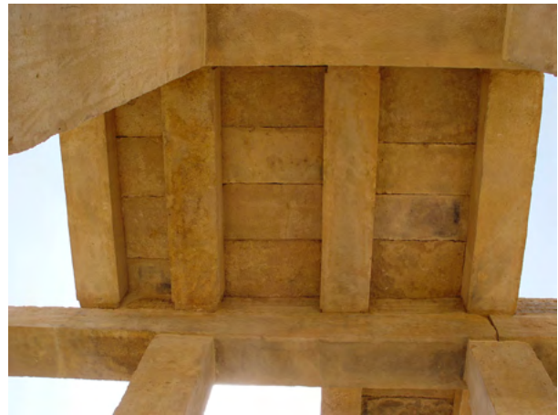
Figure 81. Veduta dal basso, all'interno del tempio, delle lastre di copertura perfettamente combacianti ricollocate nella loro posizione originaria. (S.B. Scigliano 2003 ©MAIRY)
