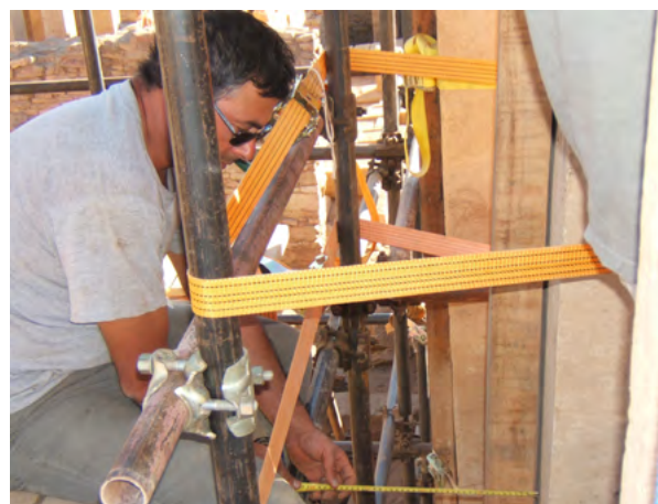
Figure 28. Spesse e larghe cinghie di tela, con tenditore a cricchetto dentato autobloccante, sono utilizzate per tirare e fissare i pilastri del propileo al ponteggio dal lato S. (A. Paladino 2006 ©MAIRY)
