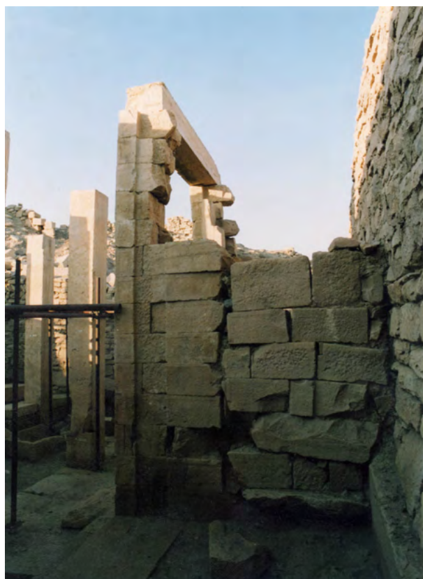
Figure 50. Il muro occidentale della cella centrale del tempio, prima dell'intervento di restauro. (S.B. Scigliano 2003 ©MAIRY)
