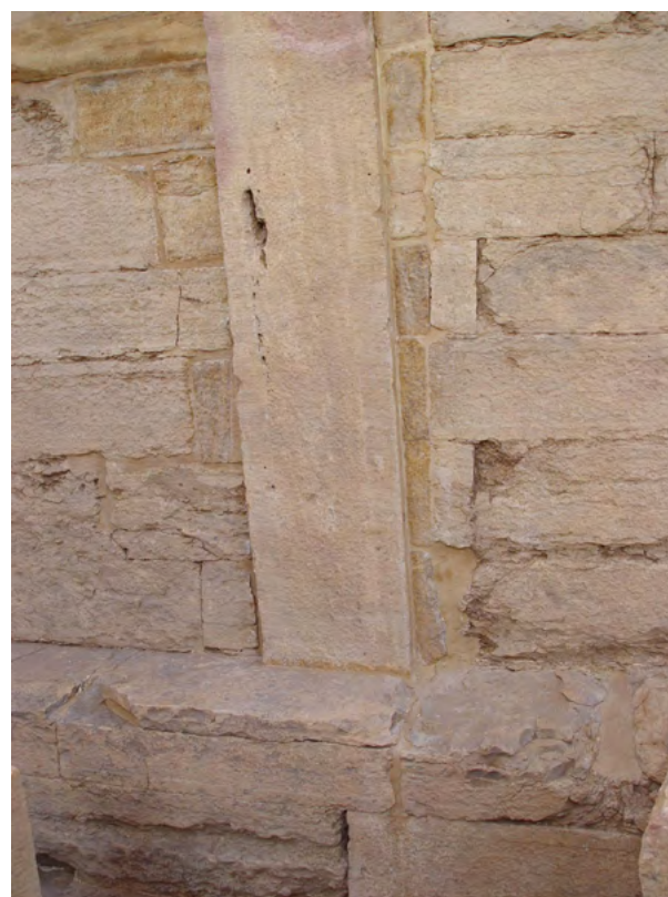
Figure 36. Dettaglio del pilastro P1 dopo il restauro. (S.B. Scigliano 2003 ©MAIRY)
