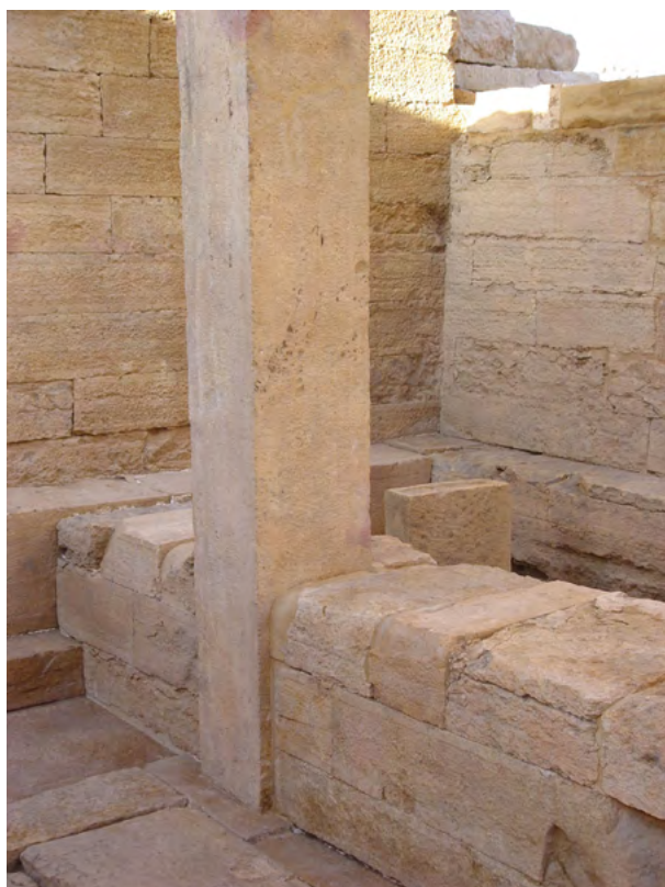
Figure 30. Il pilastro P5 nella posizione originaria a fine restauro. (S.B. Scigliano 2003 ©MAIRY)
