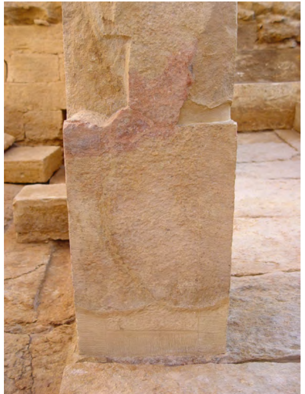
Figure 24. Il pilastro P11 a fine restauro. (S.B. Scigliano 2003 ©MAIRY)
