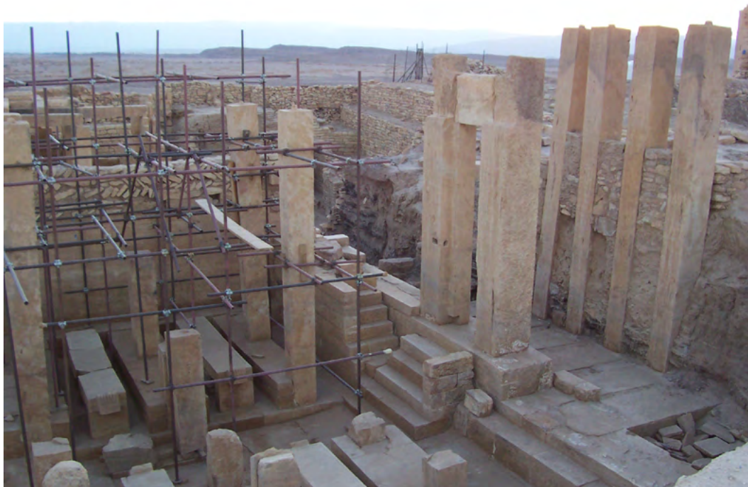
Figure 6. I pilastri occidentali, alcuni dei quali fratturati e inclinati, sono mantenuti in posizione verticale da tubi metallici (S.B. Scigliano 2006 ©MAIRY)
