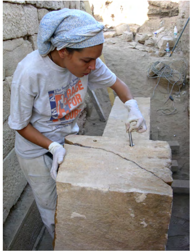
Figure 18. Nel pilastro P11 sono state inserite due barre in acciaio inox, dall'esterno verso l'interno, in fori appositamente praticati. (S.B. Scigliano 2003 ©MAIRY)
