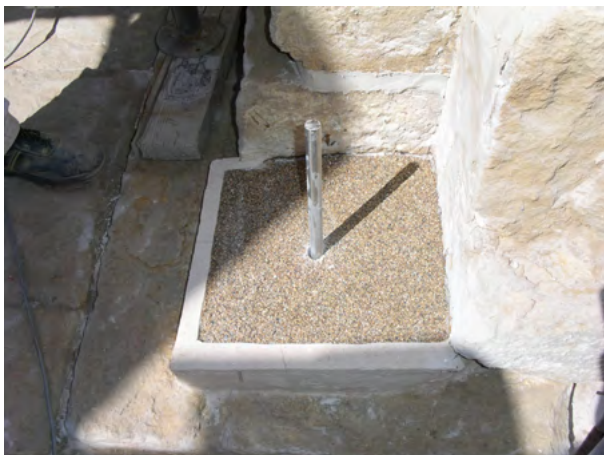
Figure 12. Base d'appoggio artificiale del P7 formata da un cordolo di malta idraulica, all'interno del quale è stato versato uno strato d'ancoraggio composto di resina epossidica e graniglia di pietra. (A. Paladino 2003 ©MAIRY)
