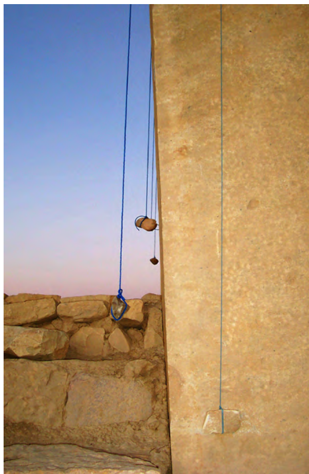
Figure 16. I 'fili a piombo' mostrano la posizione decentrata del baricentro di ogni singolo pilastro. (S.B. Scigliano 2006 ©MAIRY)
