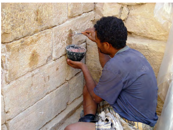
Figure 54. I conci di reintegrazione sono stati marcati con stuccatura in sottosquadro con malta di colore rosso-ossido per renderli riconoscibili. (S.B. Scigliano 2003 ©MAIRY)
