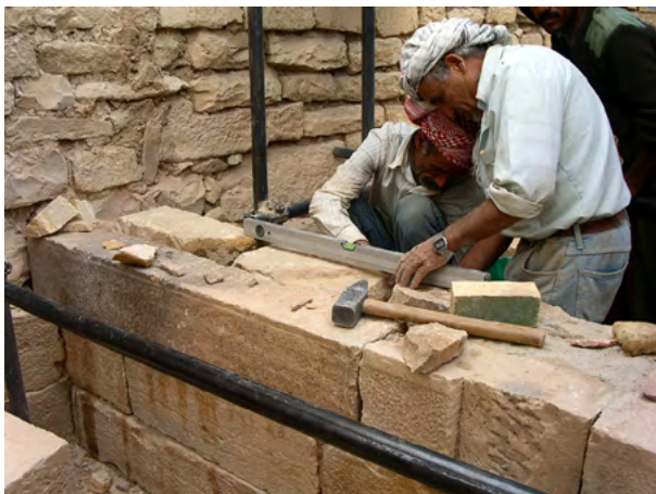
Figure 52. Gli operai specializzati del GOAM ricostruiscono la parete occidentale della cella centrale del tempio. (S.B. Scigliano 2003 ©MAIRY)
