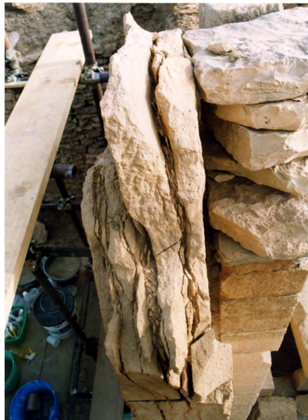
Figure 45. Stato di conservazione con fratture multiple e disgregazione del materiale lapideo della porzione superiore dello stipite orientale della porta del tempio. (S.B. Scigliano 2003 ©MAIRY)
