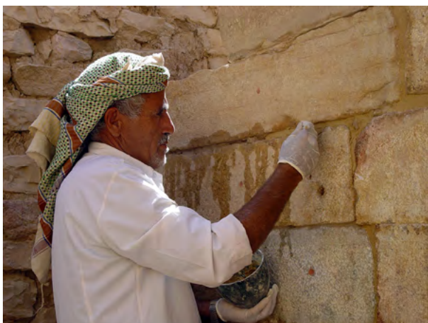
Figure 53. Fase di stuccatura e trattamento del muro occidentale della cella centrale del tempio eseguita da un operaio specializzato del GOAM. (S.B. Scigliano 2003 ©MAIRY)
