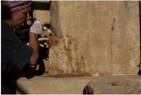
Figure 33. All'interno dei distacchi della pietra la restauratrice Alessandra Paladino inietta resina micro acrilica e malta idraulica fluida per preservare i manufatti da infiltrazioni corrosive. (di S.B. Scigliano 2006 ©MAIRY)
