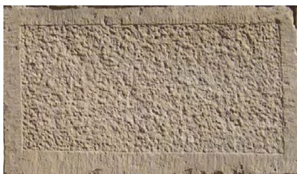
Figure 24. Bloc piqueté au ciseau à bout rond, de calcaire oolithique avec une ciselure périmétrique. (G. Richoux 2004–2005 ©MAIRY)
