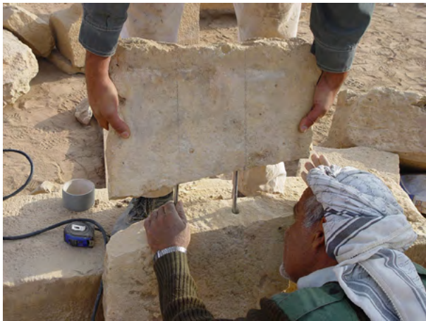
Figure 79. Risanamento di due frammenti di una lastra di copertura, tramite due perni di acciaio (A. Paladino 2003 ©MAIRY)
