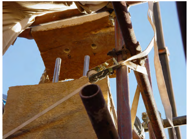
Figure 67. Prova di riassettaggio, effettuato in verticale, della trave principale posta sopra i due pilastri P6 e P10 e sopra il muro O della cella. (A. Paladino 2003 ©MAIRY)
