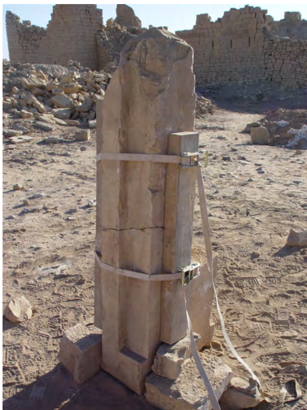
Figure 58. Fase di riadesione dei due frammenti della cornice modanata orizzontale superiore, posta sotto l'architrave della porta della cella centrale del tempio. (S.B. Scigliano 2003 ©MAIRY)
