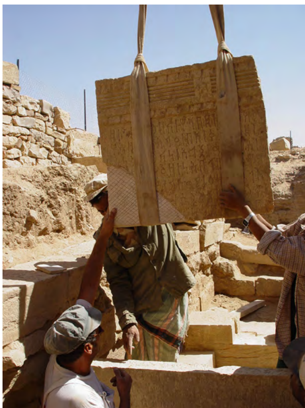
Figure 89. Fase di ricollocamento del blocco iscritto con integrazione lapidea al di sopra del blocco iscritto di maggiori dimensioni. (A. Paladino 2003 ©MAIRY)
