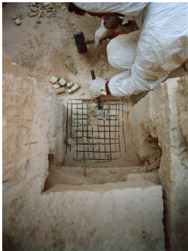
Figure 33. La base su cui appoggiare il pilastro P1 è stata ribassata di 2 cm mediante quadrettatura e rimozione dei cubetti lapidei con scalpello. (A. Paladino 2003 ©MAIRY)
