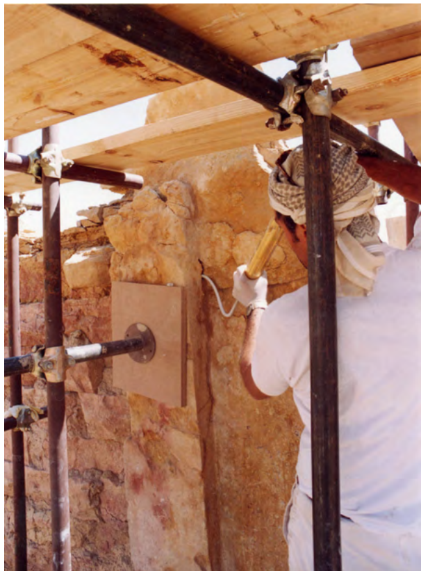
Figure 44. Infiltrazioni di malta idraulica fluida negli spazi distaccati e nelle fratture parziali della parte superiore dello stipite orientale della porta. (A. Paladino 2003 ©MAIRY)
