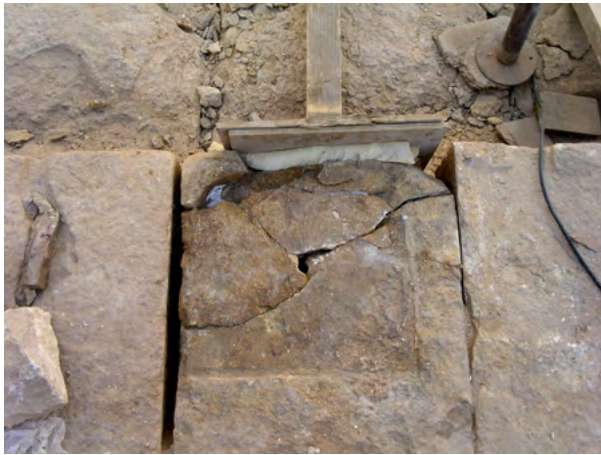
Figure 21. Consolidamento dei frammenti della base di appoggio del pilastro P11. (S.B. Scigliano 2003 ©MAIRY)
