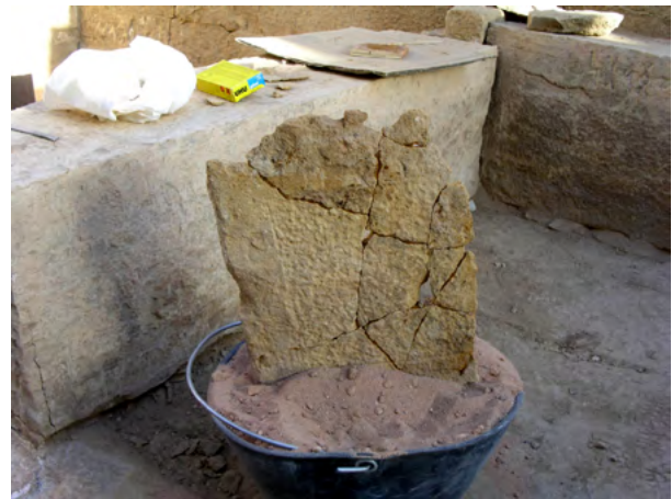
Figure 40. Frammenti ricomposti di una porzione superficiale distaccata del pilastro P12. (A. Paladino 2003 ©MAIRY)
