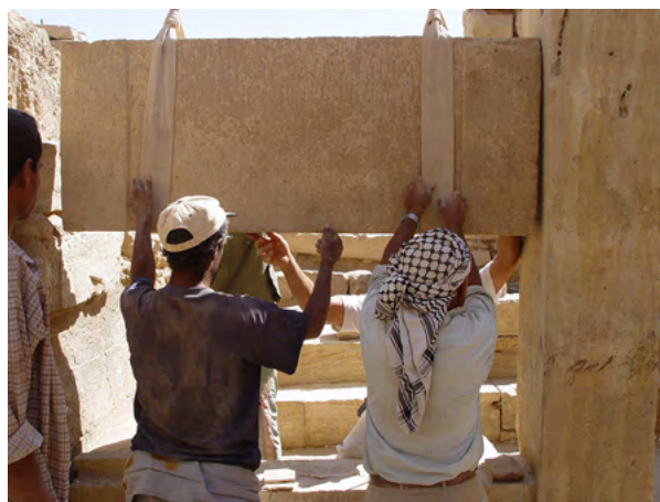
Figure 86. Fase di ricollocamento del blocco iscritto di maggiori dimensioni nella sua posizione originaria, tra il pilastro P12 ed il muro orientale del tempio. (A. Paladino 2003 ©MAIRY)
