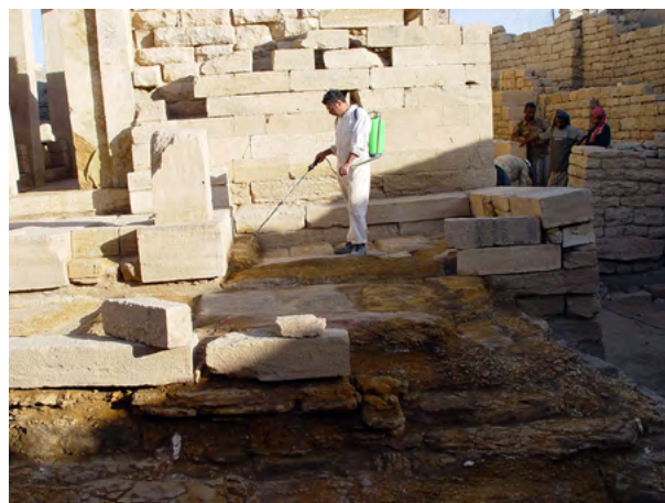
Figure 95. Il restauratore Saverio Bruno Scigliano durante il trattamento conservativo dello stilobate per impregnazione, mediante imbibizione per nebulizzazione. (A. Paladino 2003 ©MAIRY)
