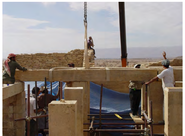
Figure 68. Ricollocazione nella posizione originaria della trave principale posta sopra i due pilastri P6 e P10 e sopra il muro O della cella. (A. Paladino 2003 ©MAIRY)
