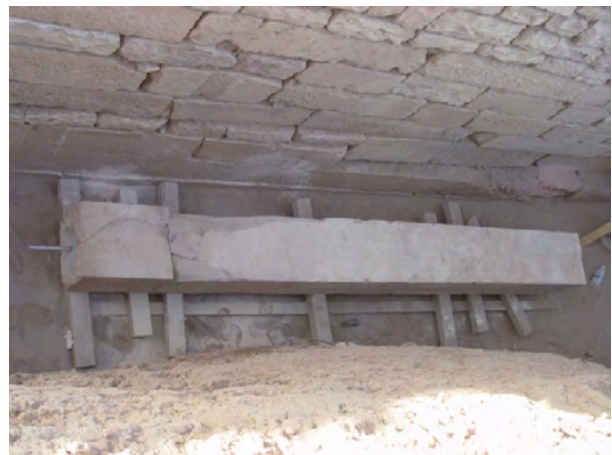
Figure 19. Il pilastro P11 disposto orizzontalmente e assemblato al di fuori del tempio. (A. Paladino 2003 ©MAIRY)
