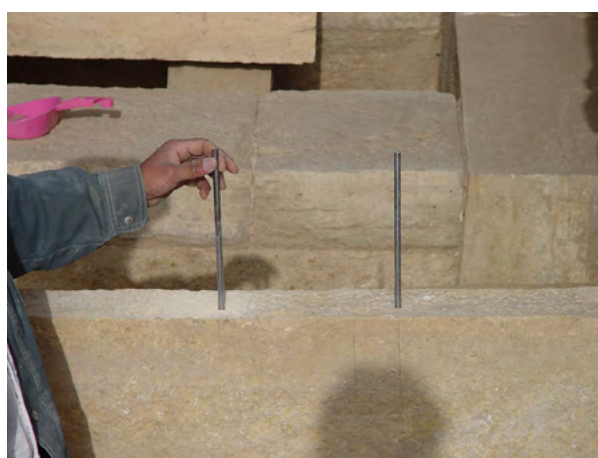
Figure 87. Due barre verticali in acciaio inox sono state inserite tra la sezione inferiore e il monoblocco di pietra posto sopra la pavimentazione. (A. Paladino 2003 ©MAIRY)
