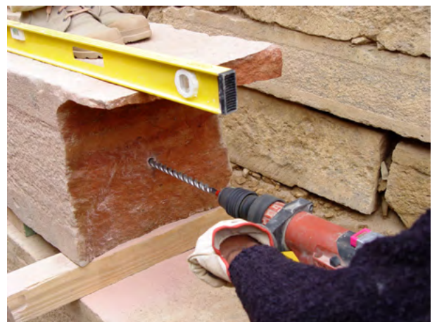
Figure 9. Foro praticato al centro del pilastro P7 per l'inserimento di una barra in acciaio inox. (A. Paladino 2003 ©MAIRY)
