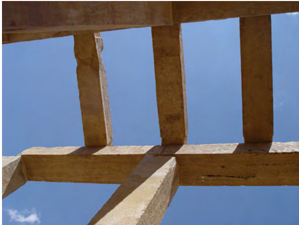
Figure 74. Veduta dal basso, all'interno del tempio, di alcune travi secondarie ricollocate nella loro originaria posizione sopra le travi primarie. (S.B. Scigliano 2003 ©MAIRY)
