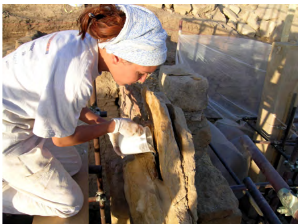
Figure 46. All'interno di entrambi gli stipiti, nelle fessure è stato versato dall'alto uno strato di conglomerato LEDAN C30 di consistenza fluida, e una parte di polvere di pietra finissima. Dopo qualche giorno, vi è stata versata resina epossidica ad alto potere adesivo caricata con quarzite super ventilata. (S.B. Scigliano 2003 ©MAIRY)
