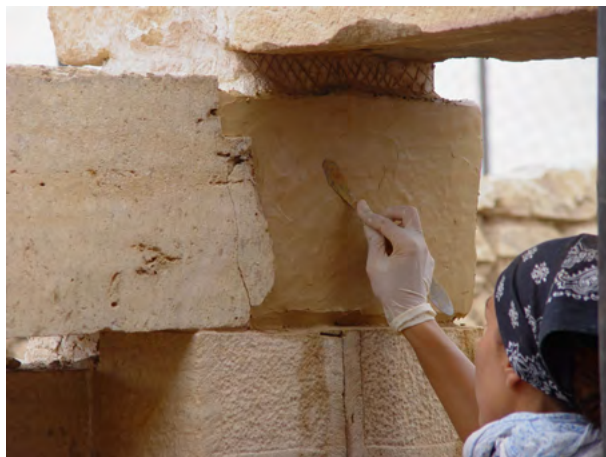
Figure 61. Integrazione lapidea e stuccatura della porzione mancante dell'architrave della porta della cella centrale del tempio. (S.B. Scigliano 2003 ©MAIRY)
