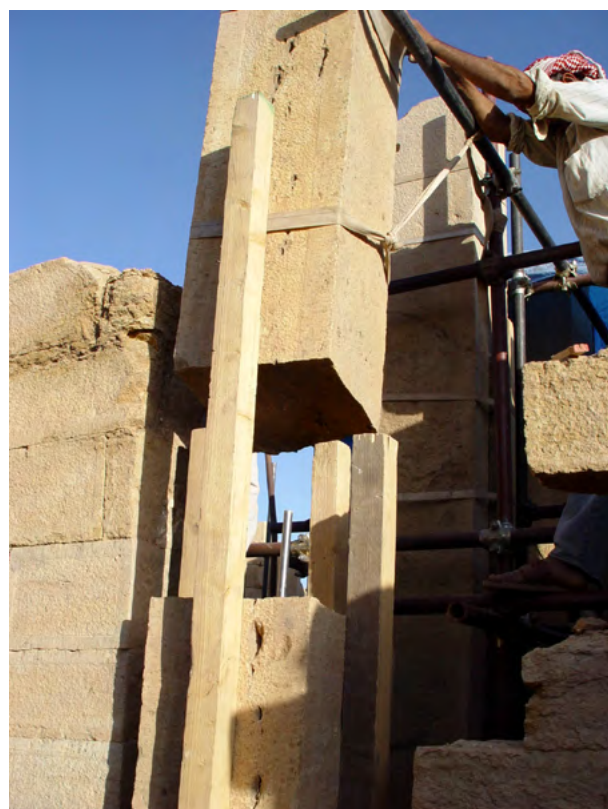
Figure 34. Ricollocamento della parte superiore su quella inferiore del pilastro P1. (A. Paladino 2003 ©MAIRY)
