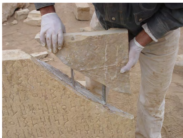
Figure 85. Integrazione del materiale lapideo della lacuna dell'angolo inferiore sinistro di una iscrizione. (A. Paladino 2003 ©MAIRY)
