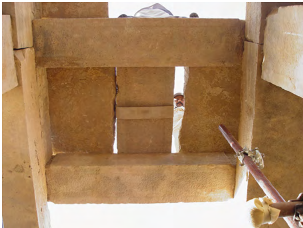
Figure 80. Riposizionamento delle lastre di copertura del tempio nella loro posizione prima dello smontaggio. (S.B. Scigliano 2003 ©MAIRY)
