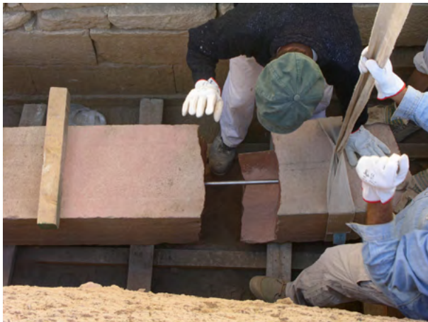
Figure 11. Foro praticato nella sezione della frattura della parte superiore di P7, combaciante e continuo con quello della parte centrale. (A. Paladino 2003 ©MAIRY)
