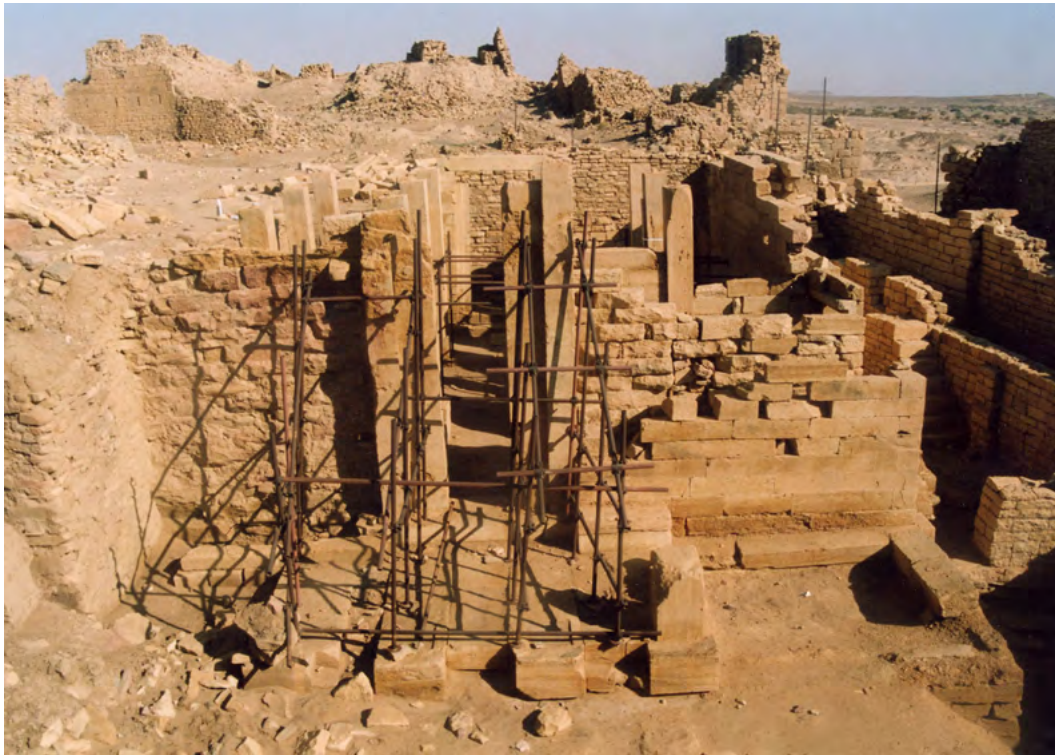
Figure 1. Vista del tempio di Nakrah prima del restauro. Evidente è l'inclinazione verso NE. (S.B. Scigliano 2003 ©MAIRY)
