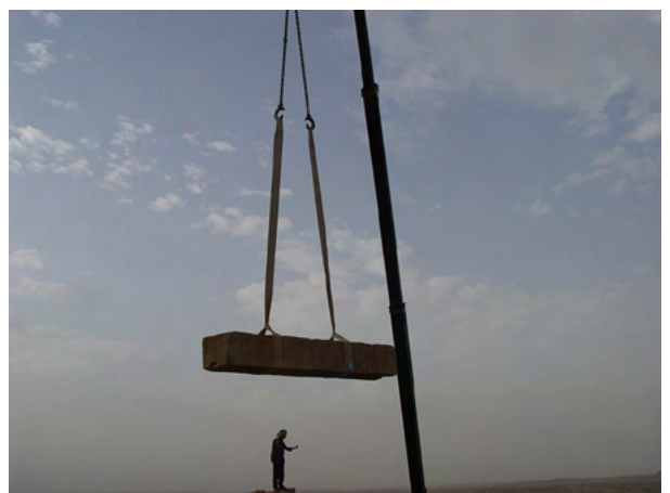
Figure 69. Il personaggio in piedi sulle mura di Barāqish dà indicazioni di movimentazione di una trave al macchinista del carro-gru il quale, trovandosi al di fuori e ai piedi delle mura, non ha alcuna possibilità di vedere quanto accade nell'area interna alla città. (S.B. Scigliano 2003 ©MAIRY)
