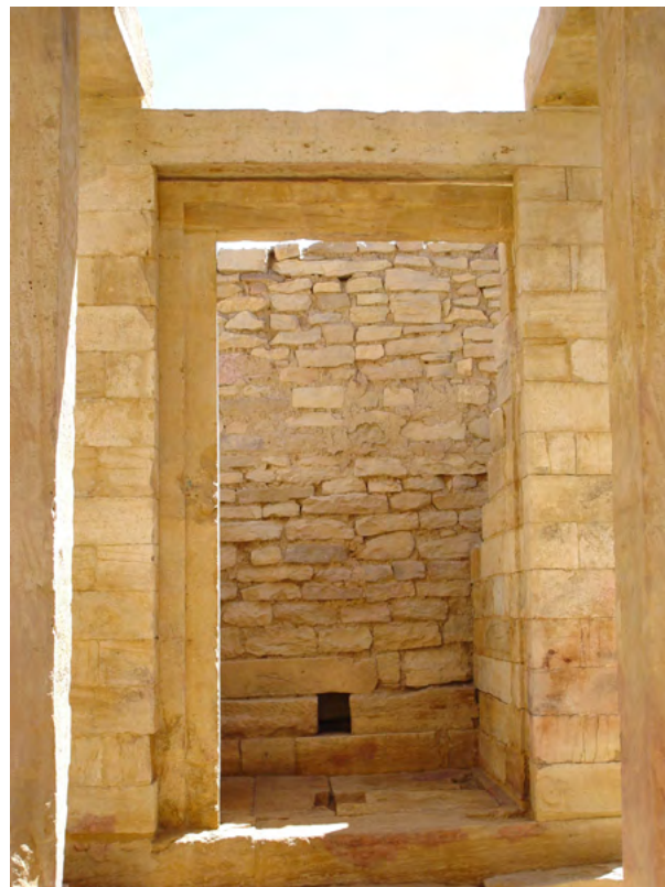
Figure 63. La porta della cella con la cornice e l'architrave in situ dopo il restauro. (S.B. Scigliano 2003 ©MAIRY)
