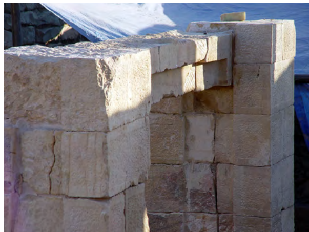
Figure 60. La cornice modanata, ricollocata nella posizione originale, poggia sopra due blocchi di pietra opportunamente scanalati dagli architetti minei, posti nella penultima fila dei due muri laterali della cella centrale. (S.B. Scigliano 2003 ©MAIRY)
