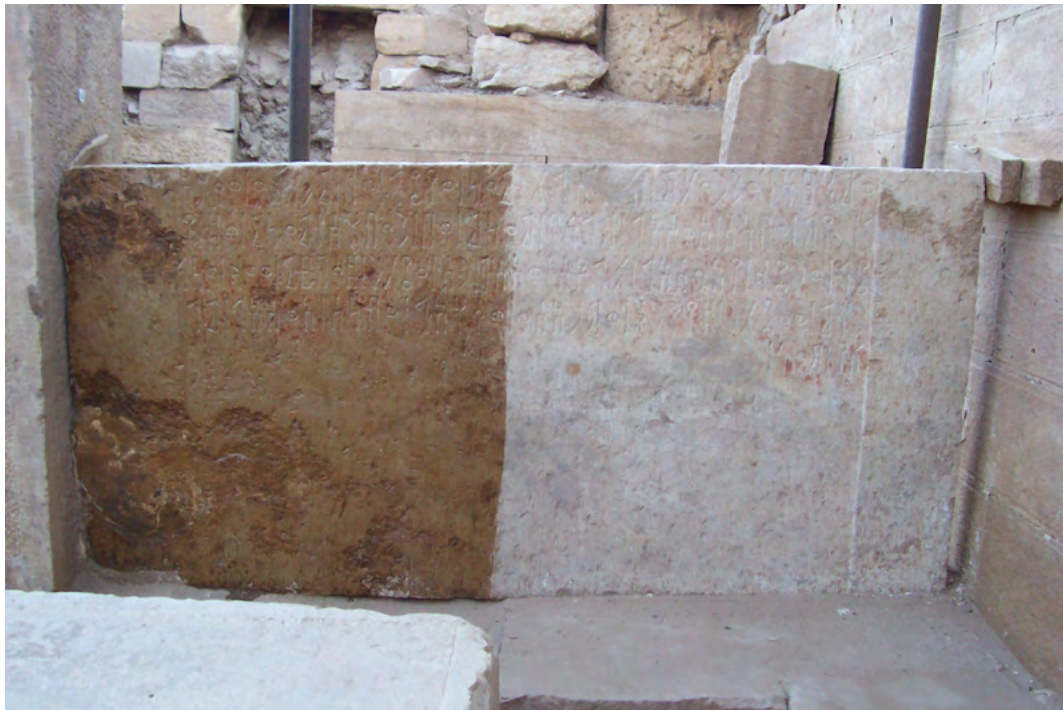
Figure 39. Intervento di pre-consolidamento coesivo con consolidante applicato sul blocco iscritto Y.05.B.B./12 (M121, tra P4 e il muro perimetrale O del tempio). (S.B. Scigliano 2006 ©MAIRY)
