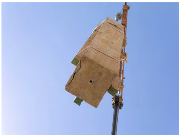
Figure 41. Vista dal basso del pilastro P12 con il foro centrale e la ricomposizione della porzione superficiale restaurata. (A. Paladino 2003 ©MAIRY)
