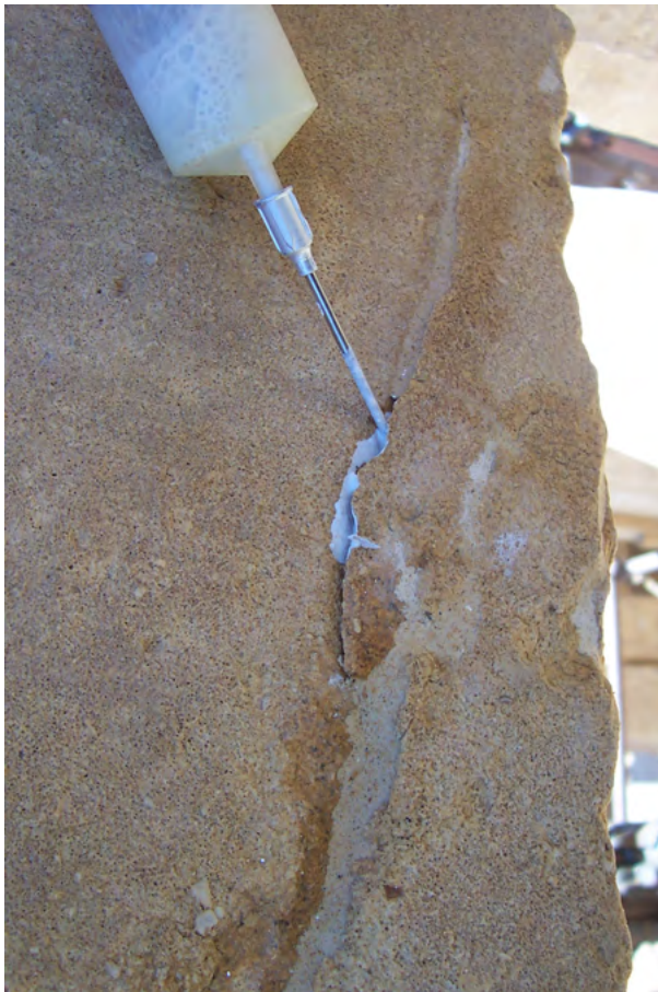
Figure 34. Dettaglio dell'intervento di infiltrazione per iniezione di resina micro acrilica e malta idraulica fluida, per preservare i manufatti da infiltrazioni corrosive dovute ad agenti atmosferici. (S.B. Scigliano 2006 ©MAIRY)
