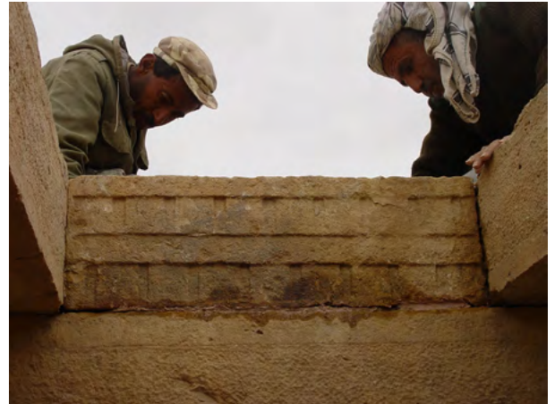
Figure 77. Una metopa ricollocata nella sua posizione originale, sopra una trave principale e nello spazio compreso tra due travi secondarie. (S.B. Scigliano 2003 ©MAIRY)
