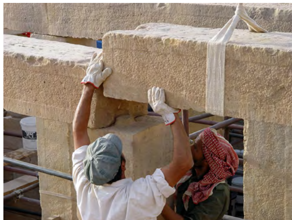
Figure 71. Posizionamento di un'altra trave primaria sul pilastro con tenone. (A. Paladino 2003 ©MAIRY)
