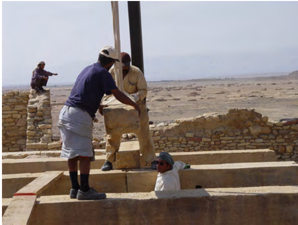
Figure 73. Fase di riposizionamento delle travi secondarie, al di sopra e trasversali alle travi primarie. (A. Paladino 2003 ©MAIRY)
