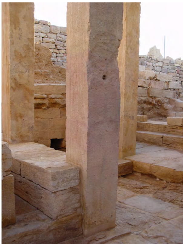
Figure 15. Risultato finale del restauro del pilastro P7. (S.B. Scigliano 2003 ©MAIRY)
