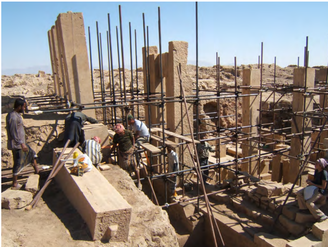
Figure 26. I pilastri del propileo sono legati alla struttura metallica che ingloba sia il portale del tempio sia i pilastri occidentali della sala ipostila. (A. de Maigret 2006 ©MAIRY)
