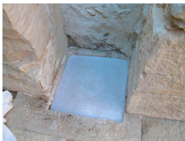
Figure 28. La base d'appoggio originaria, sulla quale si impostava il pilastro P5, è stata abbassata di 3-4 cm; vi è stata versata resina epossidica ad alto potere adesivo, caricata con quarzite ventilata e autolivellante. (A. Paladino 2003 ©MAIRY)
