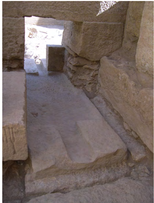
Figure 7. Exutoire des effluents collectés dans la rigole de la travée « 3 », vue depuis l'intérieur vers le nord-est du temple de Nakrah. (G. Richoux 2005-2006 ©MAIRY)
