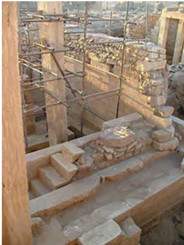
Figure 11. La scala M104 che si appoggia alla porzione sud del muro perimetrale M103, da nord. (A. de Maigret 2005 ©MAIRY)
