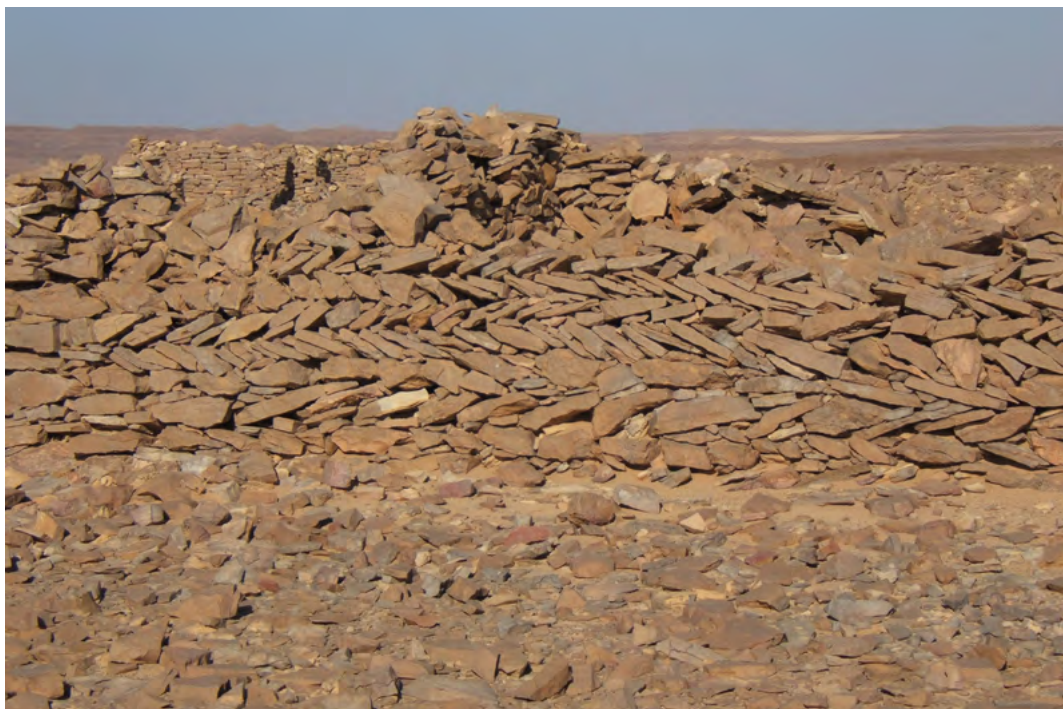
Fig. 19. Tecnica costruttiva muraria a spina di pesce di alcuni muri a Darb al-Şabī. (R. Valentini 2005 ©MAIRY)
