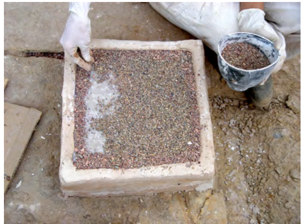
Figure 23. La base d'appoggio artificiale è riempita di resina epossidica ad alto potere adesivo, caricata con quarzite ventilata e rinforzata con scaglie e blocchetti in pietra per aumentarne la resistenza meccanica. (S.B. Scigliano 2003 ©MAIRY)
