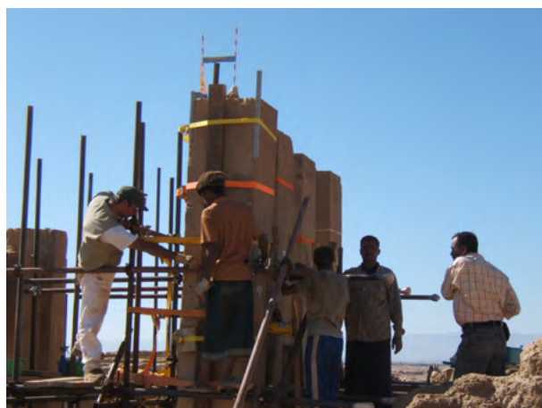
Figure 27. L'antenna posta al di sopra del pilastro viene captata dalla Stazione Totale di rilevamento per segnalare in diretta il posizionamento corretto del pilastro stesso nella fase di movimento. (A. Paladino 2006 ©MAIRY)
