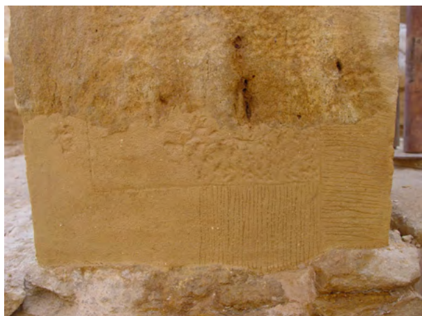
Figure 25. Dettaglio della base artificiale del pilastro P11 a fine restauro. (S.B. Scigliano 2003 ©MAIRY)
