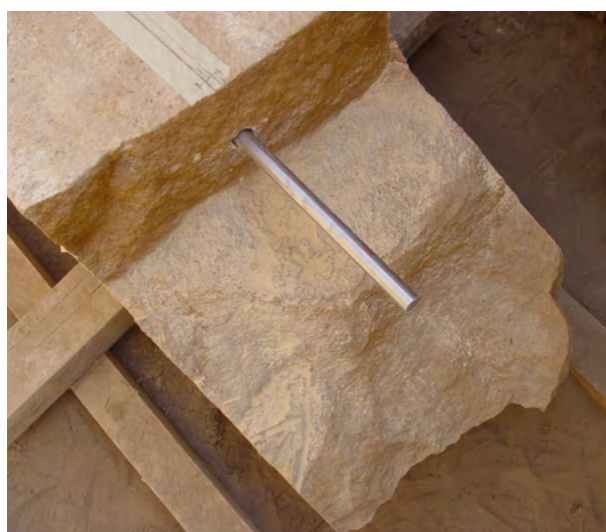
Figure 27. Nelle sezioni di contatto della frattura delle due parti del pilastro P5 è stato praticato un foro per l'inserimento della barra di acciaio inox. (A. Paladino 2003 ©MAIRY)
