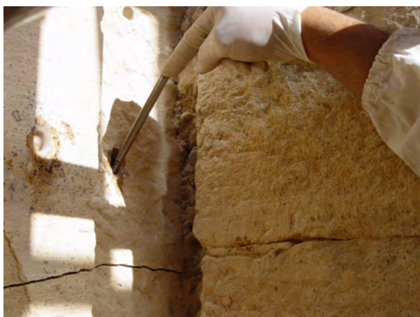
Figure 47. Inserimento di una barra d'acciaio in un foro appositamente praticato in prossimità delle quattro fratture orizzontali della porzione superiore dello stipite orientale della porta del tempio. (A. Paladino 2003 ©MAIRY)
