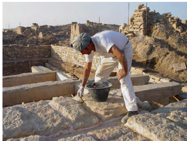
Figure 83. Fase di stuccatura delle lastre di copertura con malta idraulica di colore giallo-ocra. (A. Paladino 2003 ©MAIRY)
