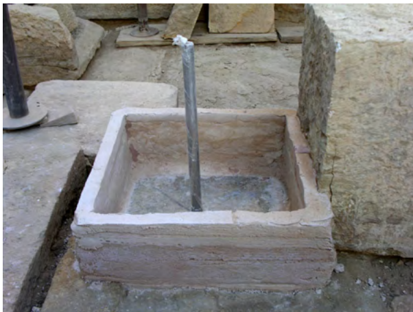
Figure 38. Cordolo perimetrale della base artificiale, realizzato con malta idraulica, per l'alloggiamento del pilastro P12; al centro la barra d'acciaio. (S.B. Scigliano 2003 ©MAIRY)
