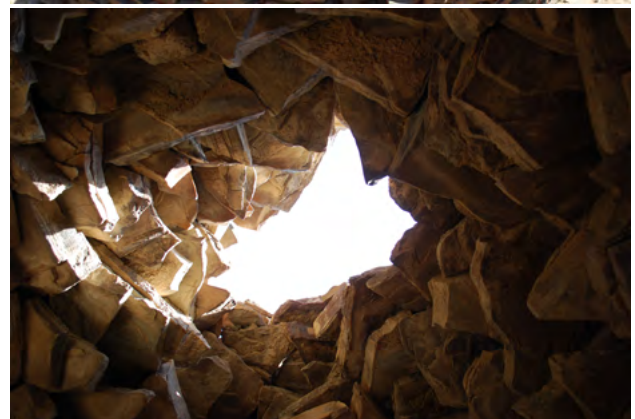
Abb. 222: Falsches Gewölbe des Grabes 07.
