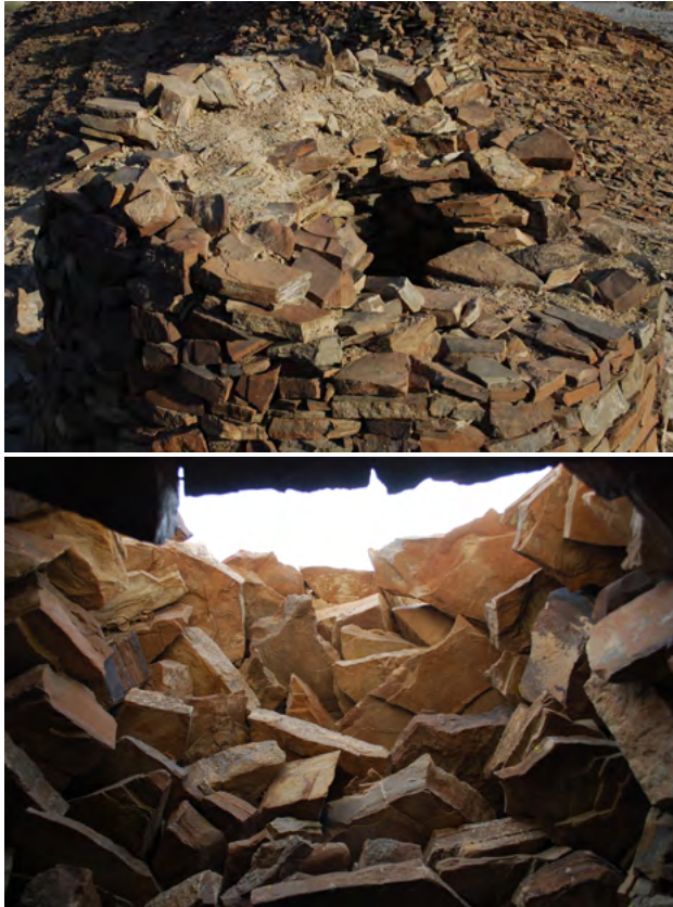
Abb. 216: Falsches Gewölbe der Grabkammer des Grabes 06.
