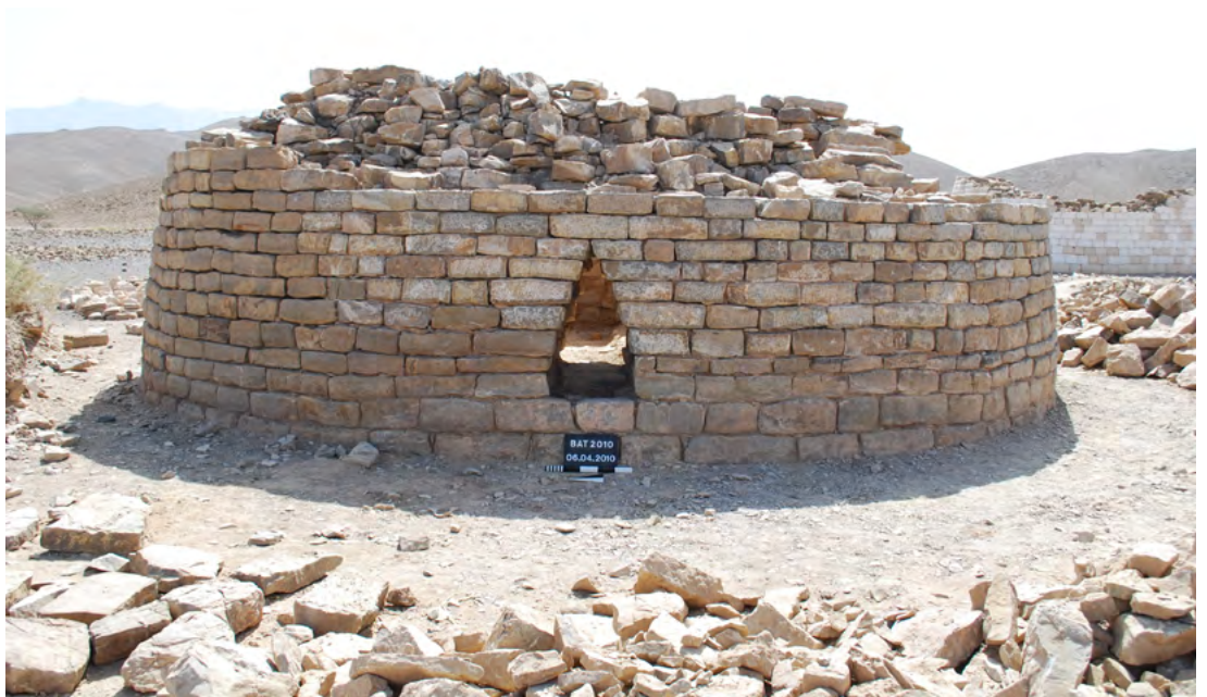
Abb. 92: Außenmauer A-Inst. 0002 des Grabes 156, teilweise neu aufgemauert.
