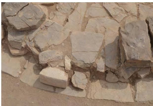
Abb. 10: Eingang Raum F (A-Inst. 0032) mit letztem vorhandenem weißem Stein der Außenfassade in diesem Bereich.
