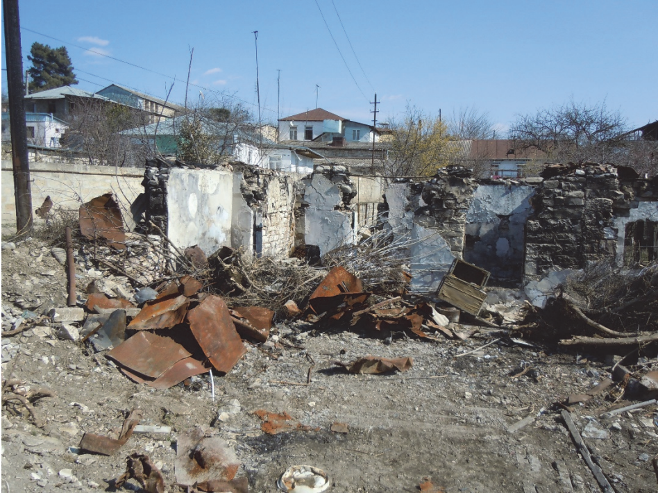
Durch Bomben zerstörtes Haus in Martuni Ռմբակոծումից ոչնչանցված տուն Մարտունի քաղաքում
