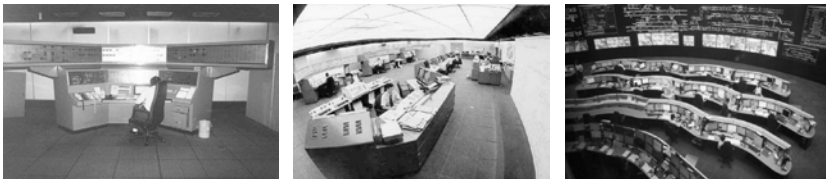
Abbildung 38: Kontrollzentrale des chinesischen Mass Transit Railway in Hong Kong 1979, 1985 und 2012.
