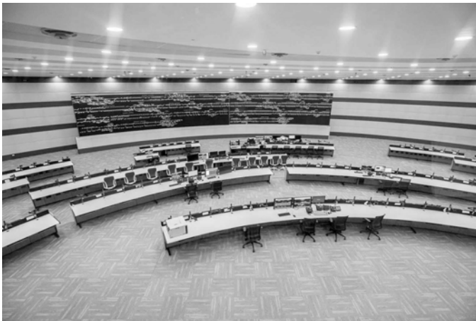
Abbildung 19: Operation Control Centre für Teile des Zug-Streckennetzes in Indien.
