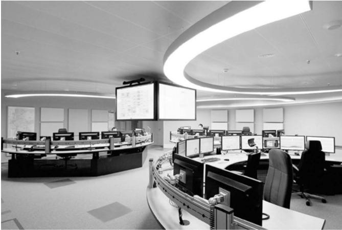
Abbildung 50: Gasnetz-Leitwarte des Unternehmens Ontras GmbH in Leipzig.
