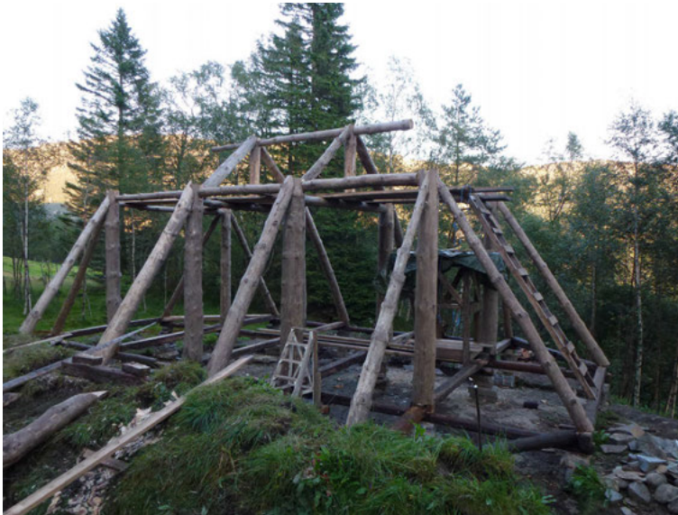
Abb. 40: Eine nordistische Baustelle (Foto: Balduin Landolt)
