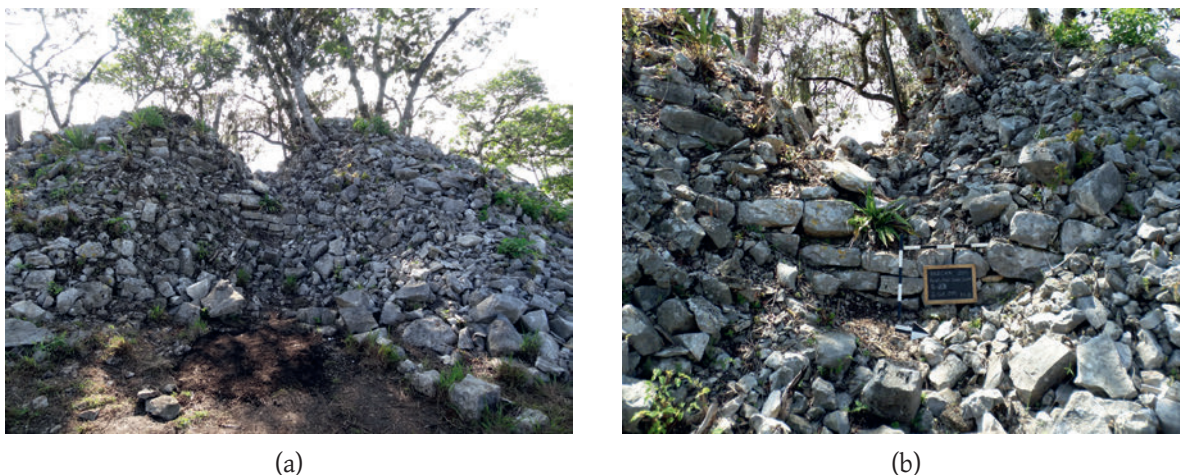
Figura 5.6. Pueblo Viejo Quen Santo, (a) la trinchera de Seler en la Estructura B-23, fotografía por U. Wölfel, con (b) muro frontal visible, fotografía por M. Guzmán.
