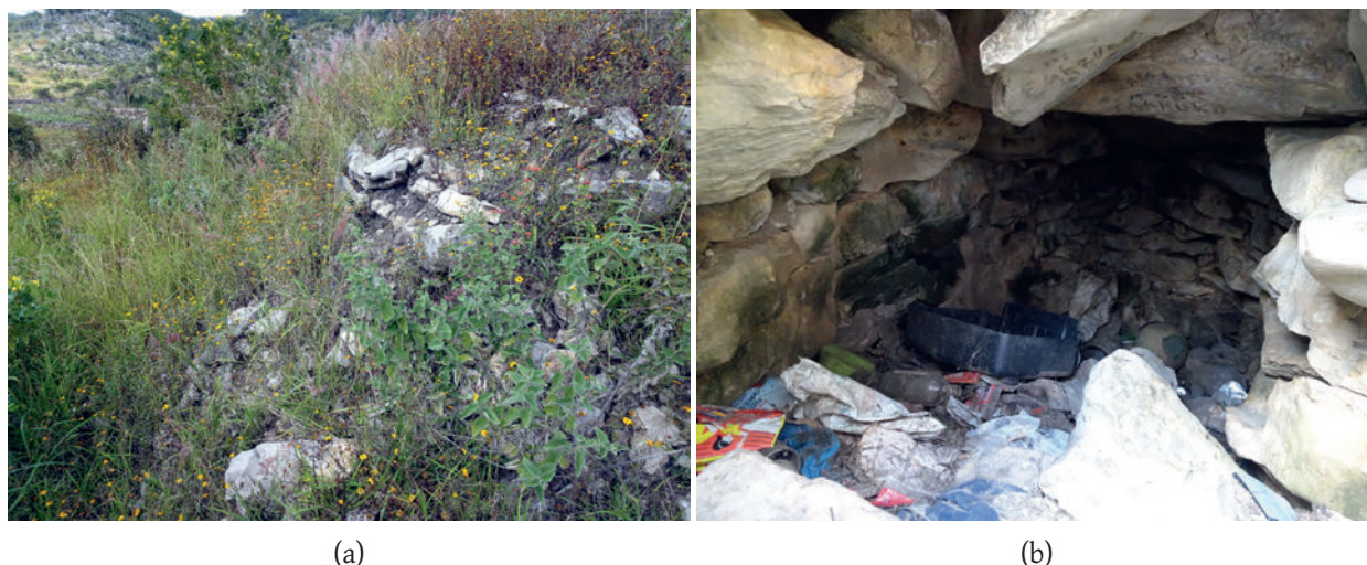
Figura 4.4. Uaxac Canal, Grupo de Colina 1, lado de la Ventana, (a) escalinata del edificio principal, (b) subterráneo abierto en la parte posterior del edificio principal, fotografías por U. Wölfel.
