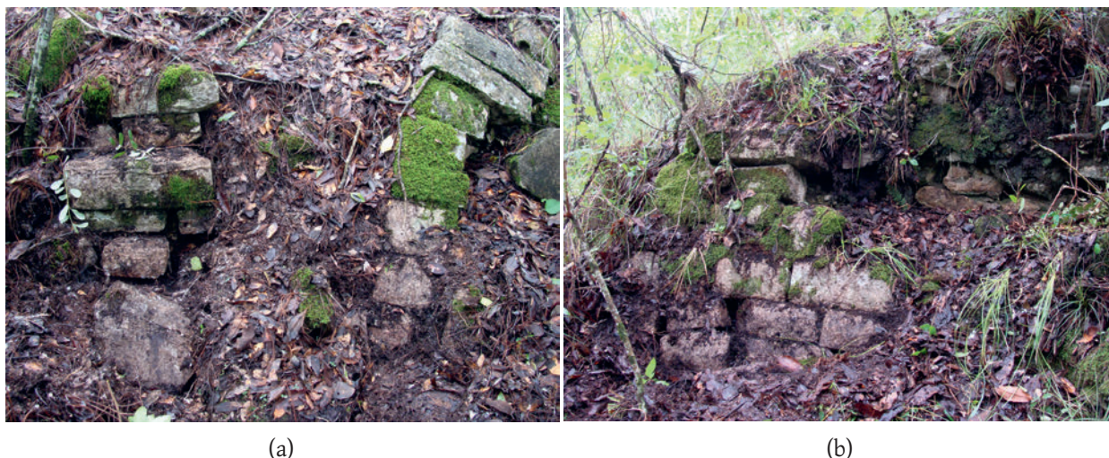
Figura 4.9. Chaculá, Templo del Este: (a) escalinata con alfarda en la parte oriental del edificio al oriente de la plataforma; (b) muro del mismo edificio, fotografías por U. Wölfel.
