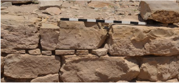
Abb. 95: Beispiel für die Verwendung von kleineren, flachen Steinplatten zum Höhenausgleich bei Gebäude V.
