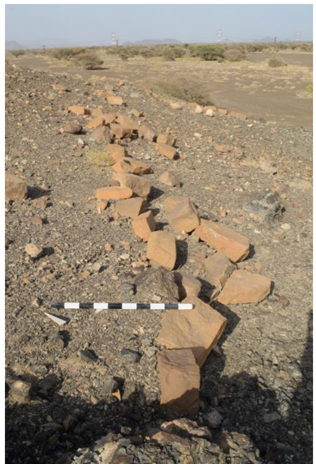
Abb. 50: Die stark gestörte Mauer G-Inst. 0044 im Südosten des Gebäudes II.
