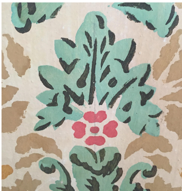
← Figur 13 (3.4.13): För att placera schabloner korrekt över en stor yta kunde markeringar i blyerts med hjälp av lod på göras på väggen. Notera att den gröna färgen inte stöplats på utan strukits på med en tjock svinborstspensel. Världsarvsgården Gästgivars. Foto: Liv Friis
