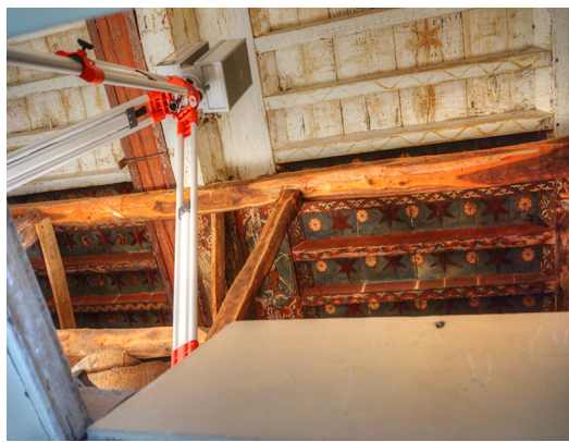
Fig. 05. A sinistra: lo scanner visto dalla botola e la parte del soffitto coperta da vernice bianca. A destra: punti di stazionamento per il rilievo con laser scanner del soffitto (immagine prodotta dagli autori).
