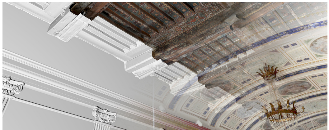
Il soffitto dipinto nascosto dalla volta in gesso (immagine prodotta dagli autori).
