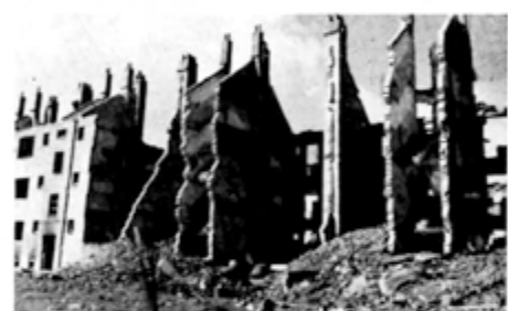
MIETHAUSBLOCK — Zerstörungsgrad ca. 80 %. Keller ganz, Außenwände teilweise erhalten.
