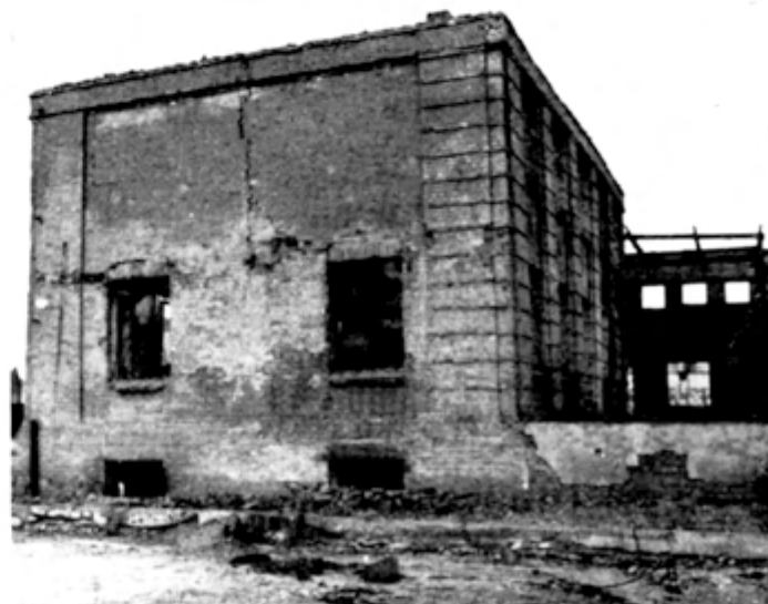
KLEINES VERWALTUNGSGEBAUDE — Zerstörungsgrad ca. 90 0/0. Zerstörung aller Decken und Außenwände.
