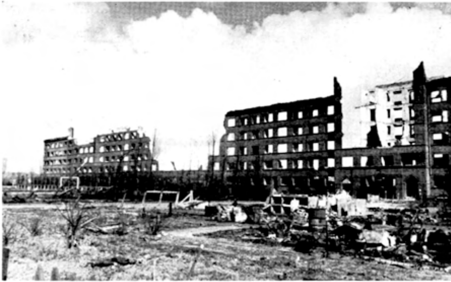
EINZELHAUS — Zerstörungsgrad ca. 90 0/0. Merkmale: Zerstörung aller Bauteile einschl. Kellerdecke und Außenwände.
