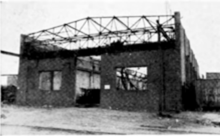
MIETWOHNHAUSER-GESCHOSSBAU — Zerstörungsgrad ca. 55 %. Merkmale: Keller voll erhalten, Decken über Küdten und Bädern erhalten, Treppenhäuser teilweise erhalten.
