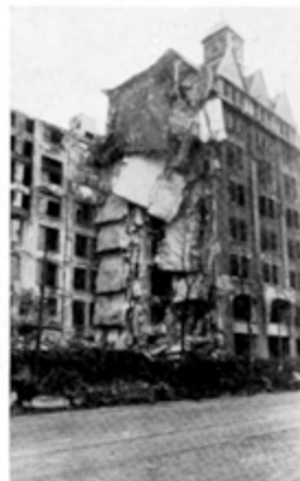
SPEICHER-GESCHOSSBAU — Zerstörungsgrad ca. 60 %. Merkmale: Fundamente und Hauptkonstruktionen einschl. Decken weitgehend erhalten.
