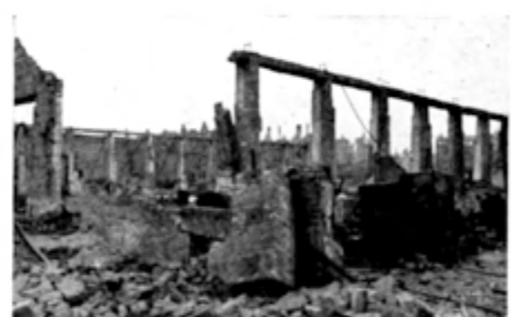
INDUSTRIESCHUPPEN — Zerstörungsgrad ca. 75 %. Fundamente und Säulen weitgehend erhalten.
