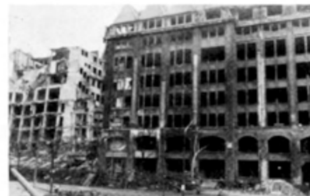
BÜROHAUS-GESCHOSSBAU — Zerstörungsgrad 65 %. Merkmale: Keller voll erhalten, ferner ein großer Teil der Skelettkonstruktion einschl. Decken.
