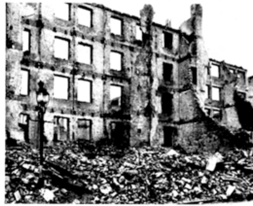
MIETWOHNHAUS — Zerstörungsgrad 95 0/0. Merkmale: Zerstörung aller Bauteile außer 1 Außenwand, Haus ohne Keller.
