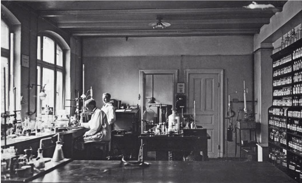
Beamte, wie man damals die Angestellten bei P. Beiersdorf & Co. nannte, waren neben den Kontoren vor allem in den Laboren tätig. Im Bild: Chemiker 1914
