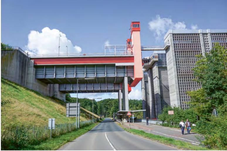
Abb. 5: Schiffshebewerk Lüneburg, Kanalbrücken als Übergang zur oberen Kanalhaltung, Foto 2021.
