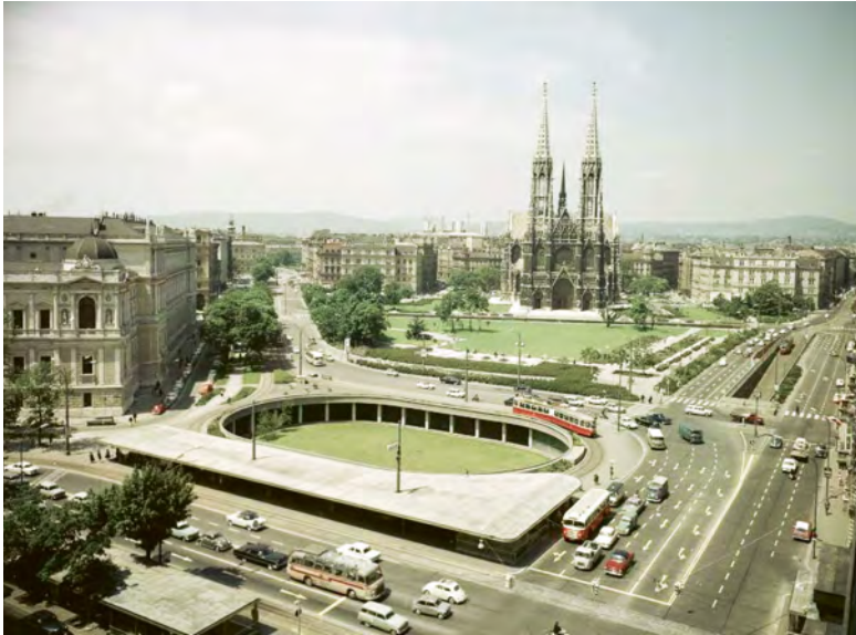
Abb. 6: Schottenpassage, Blick von einem erhöhten Standort bei der Schottenkreuzung über das Oval der Unterführung gegen den Rooseveltplatz mit der Votivkirche, Fotografie 1965.
