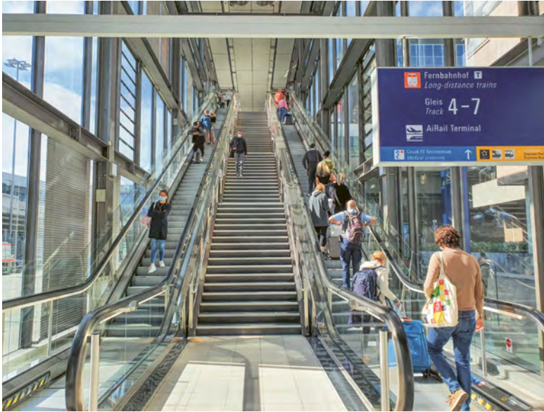
Abb. 6: JSK Architekten, Fahrtreppen am Flughafen Frankfurt in Richtung »The Squire«, 2011, aktuelles Foto.
