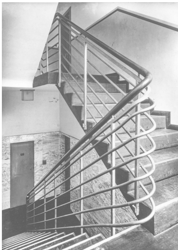
Abb. 3: Karl Schneider, Wohnhäuser Burmeister, Hamburg, 1927/28, Treppenhaus Maria-Louisen-Straße 63 mit Ansicht Schachttüre, bauzeitliches Foto.
