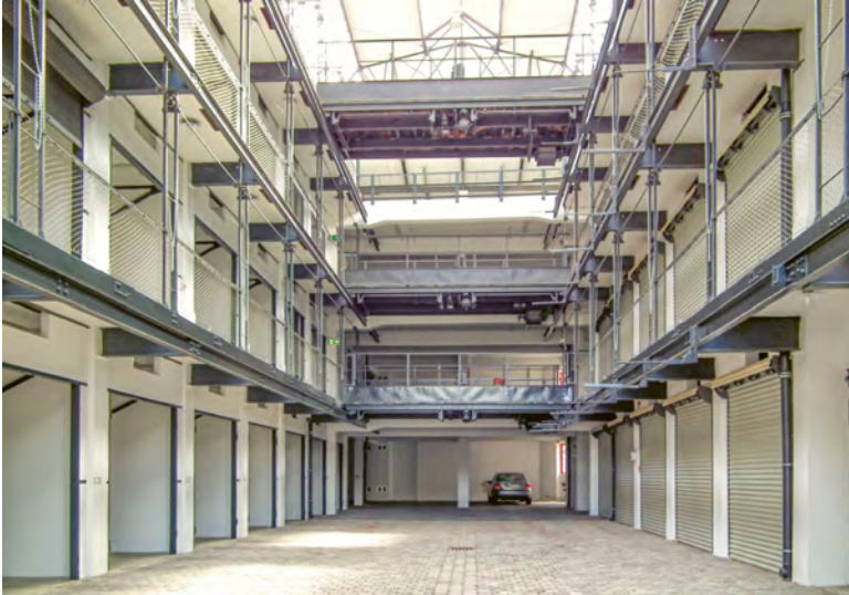
Abb. 2: Walter Tutenberg, Großgarage Süd, Halle an der Saale 1929. Garagen (Boxen) und Schiebebühnen, die die drei Obergeschosse erschließen, Foto 2012.
