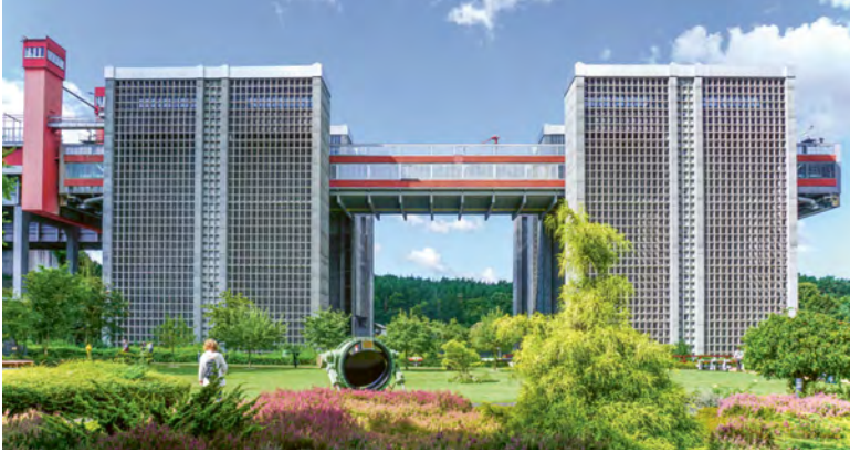
Abb. 4: Schiffshebewerk Lüneburg, Gegengewichtstürme mit Trog in Bergstellung, Foto 2021.
