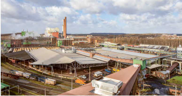
Abb. 1: Blick auf die Trocken- und Pressenhäuser der Brikettfabrik Wachtberg mit Brüdenschloten auf dem Gebäudedach und direkt anschließendem Rinnenfeld, Foto 2022.
