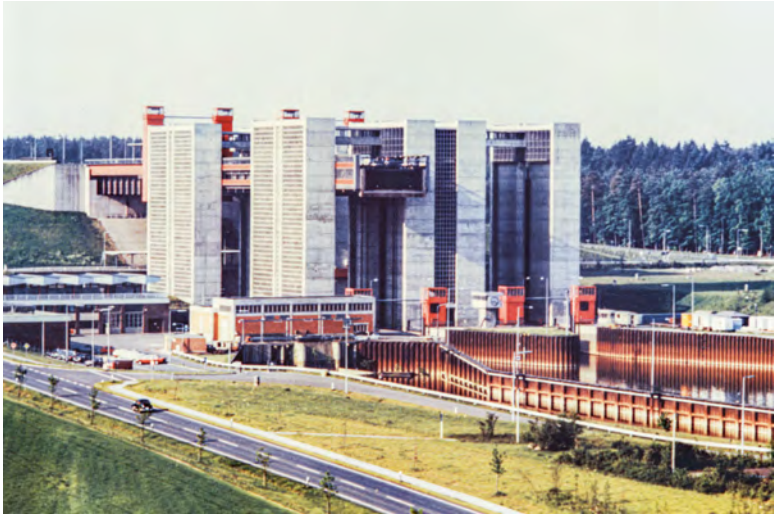
Abb. 1: Blick auf das Schiffshebewerk Lüneburg in südwestliche Richtung, Foto 1992.
