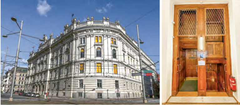
Abb. 1: Haus der Industrie, Schwarzenbergplatz, Wien. Die Paternosterkabinen präsentieren sich noch fast originalgetreu in der Ausstattung der Aufzugsfabrik Freissler von 1911, Fotos 2023.
