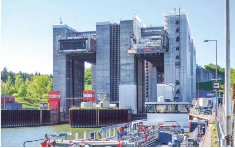
Abb. 3: Schiffshebewerk Lüneburg, Förderportale von der unteren Haltung aus gesehen, Foto 2019.
