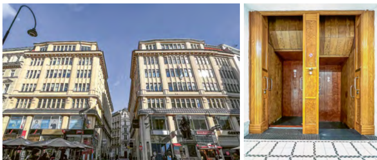
Abb. 2: Trattnerhof 1 und Trattnerhof 2, Wien, vom Graben aus gesehen. Die ursprüngliche Freissler-Ausstattung des Paternosters verbirgt sich seit der Renovierung hinter Wurzelholzfunier, Fotos 2023.
