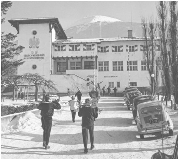
Abb. 4: Hans Fessler, Talstation der Patscherkofelbahn von Norden, Innsbruck, 1927/28, historisches Foto.
