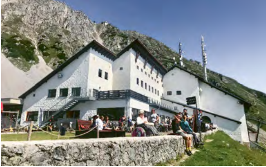
Abb. 7: Franz Baumann, Mittelstation der Nordkettenbahnen von Südtirol, Innsbruck, 1927/28, aktuelles Foto.
