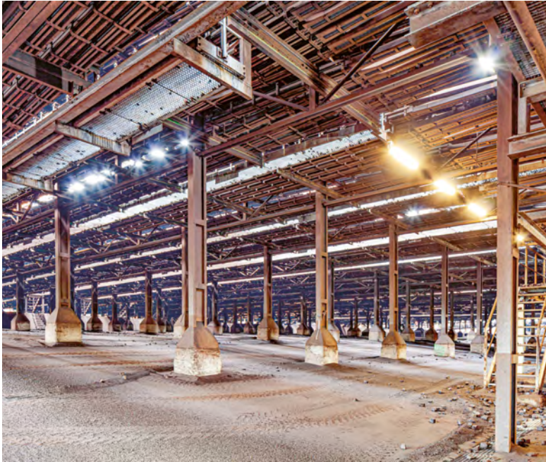
Abb. 8: Brikettfabrik Frechen-Wachtberg: Das Rinnefeld zum Abkühlen der Briketts, Blick unter den Rinnen hindurch, Foto 2022.
