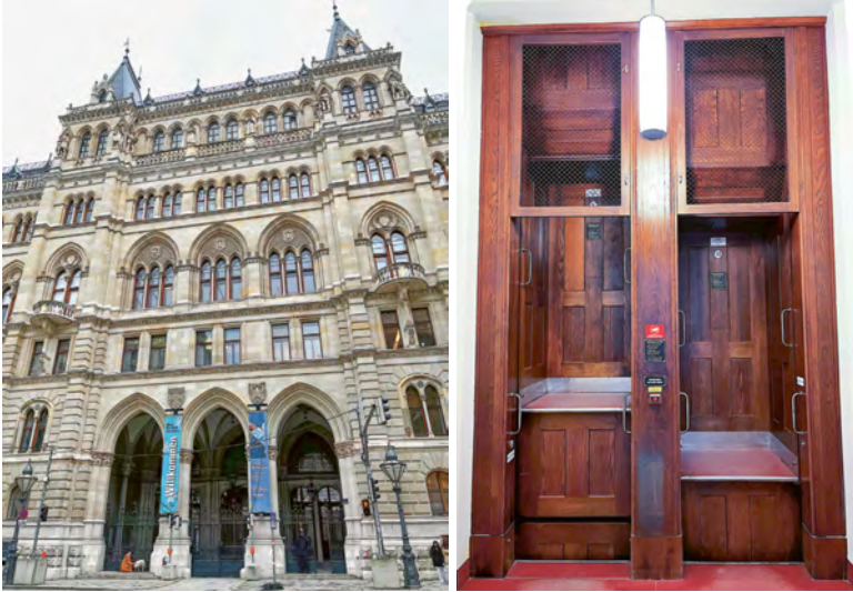
Abb. 6: Die Stiege 6 des neugotischen Wiener Rathauses beherbergt einen Paternoster der Firma Freissler in Originalausstattung aus dem Jahr 1918, Foto 2023.
