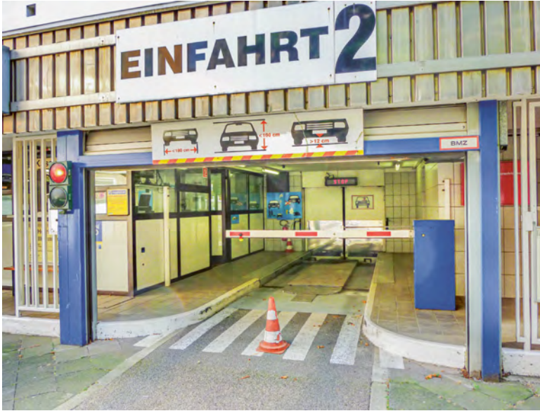
Abb. 6: Arbeitsgemeinschaft Autotiefsilo in Zusammenarbeit mit der Autosilo GmbH, Autosilo der Karstadt AG, Düsseldorf 1963. Übergabestation des zweiten Förderturms im Erdgeschoss, Foto 2011.
