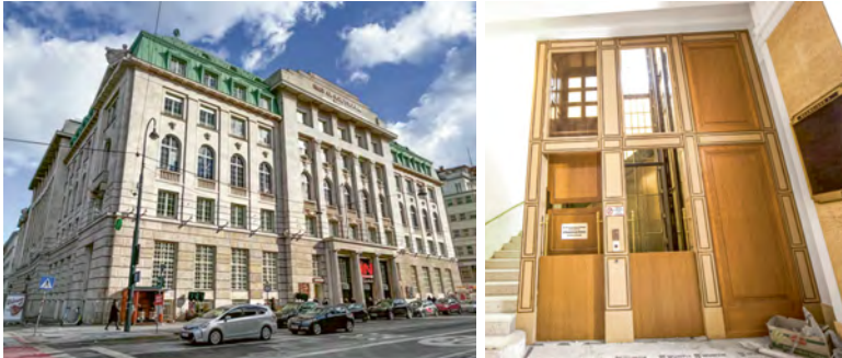
Abb. 3: Wiener Bank-Verein, Wien. Der Paternoster im lichtdurchfluteten Treppenauge des seitlichen Stiegenhauses neben den Kassensälen während der Demontage der Anlage, Fotos 2019.
