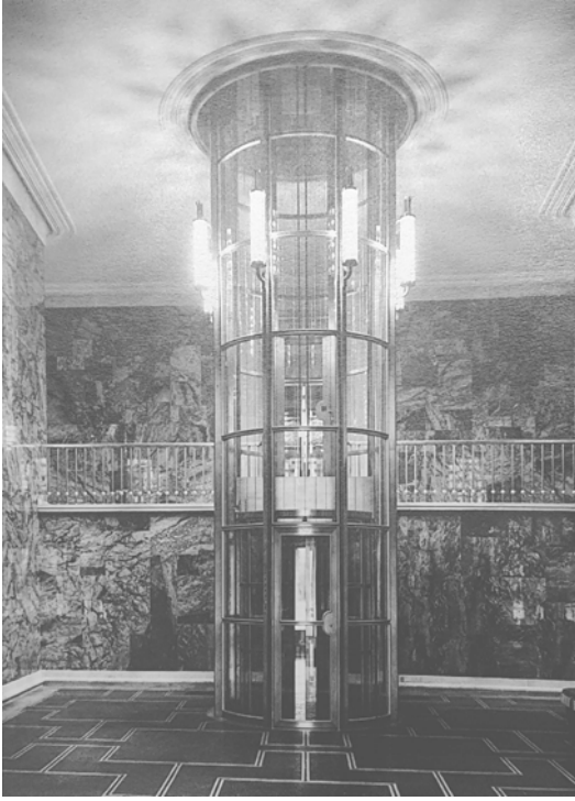
Abb. 5: Personenaufzug in freistehendem Schacht, Nordstern Versicherung AG, Berlin, Architekt: Otto Firle, Maschinenfabrik R. Stahl, 1936.
