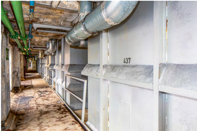
Abb. 6: Brikettfabrik Frechen-Wachtberg: Der untere Teil der Brüdenschlote im Obergeschoss des Trockenhauses, Foto 2022.
