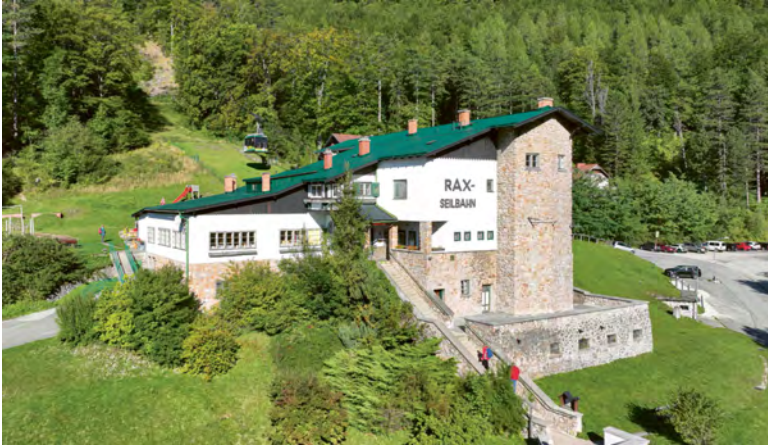
Abb. 2: Karl Koblicsek, Talstation der Raxseilbahn von Südosten, Reichenau an der Rax/Niederösterreich, 1926, aktuelles Foto.
