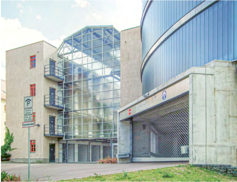
Abb. 1: Walter Tutenberg, Großgarage Süd, Halle an der Saale 1929 (links im Bild). Hochgarage mit verglastem Lichtthof der vier Garagenetagen, Foto 2012.
