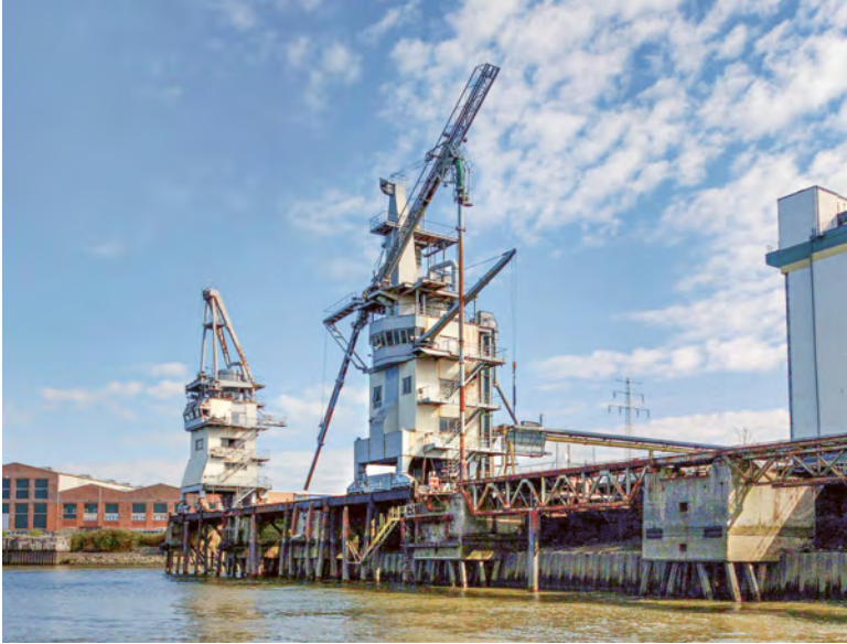
Abb. 6: Turmheber des Getreideterminals Reiherdamm, Hamburg-Steinwerder, Foto 2022.
