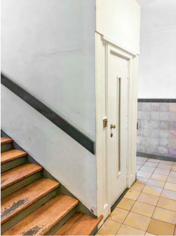
Abb. 7: Otho Orlando Kurz und Eduard Herbert, Wohnblock Schleißheimer Straße / Karl-Theodorstraße Nord, München, 1929/30, Ansicht Schachtverkleidung und -tür, Foto 2023.
