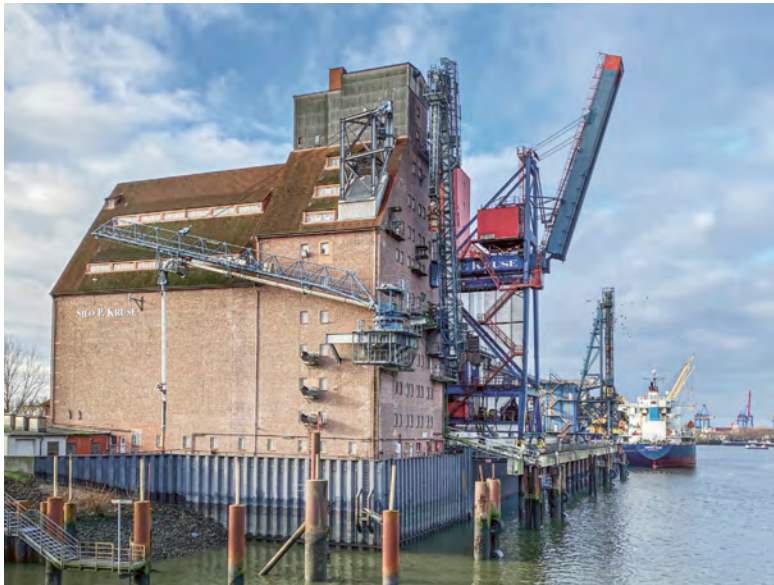
Abb. 5: Silo P. Kruse an der Rethe mit Hebern und anderer Fördertechnik, Hamburg-Wilhelmsburg, Foto 2023.
