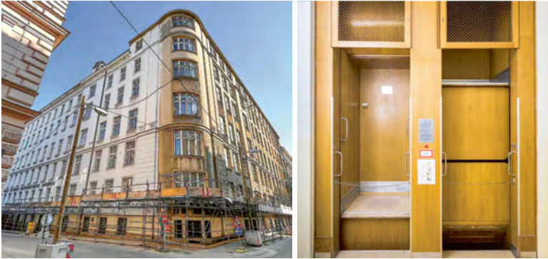
Abb. 4: Direktionsgebäude der Wiener Stadtwerke, Wien, Neunter Bezirk. Der in den 1950er Jahren neu verkleidete Paternoster mit Aschenbecher in jeder Kabine, Fotos 2020.
