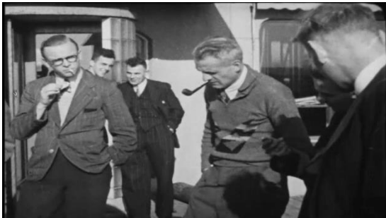
Abb. 10.4 In der Nähe des NLL befand sich deutsche Flugabwehrartillerie. Hier steht Käußl (mit Pfeife) mit anderen NLL-Mitarbeitern und betrachtet einige Trümmer, die in der Nähe des Personaleingangs auf der Rückseite des Gebäudes heruntergekommen sind (Standbild aus dem NLL-Film).
