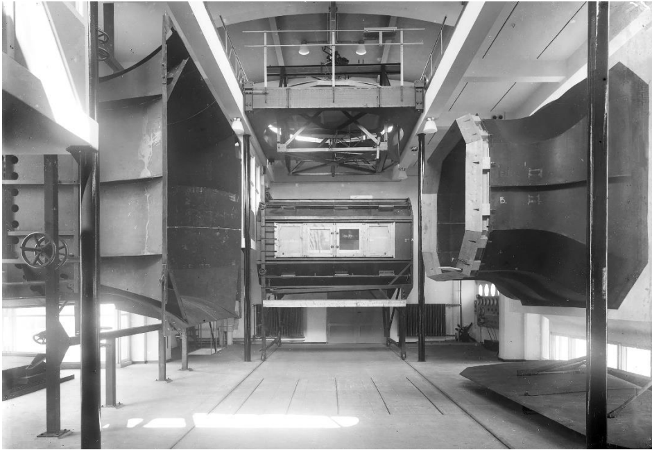
Abb. 7.5 Die Messstrecke des Großen LST in seinem „offenen“ Zustand. Der Luftstrom kommt aus der Öffnung auf der rechten Seite (der „Kontraktionsdüse“) und wird von der größeren Öffnung auf der linken Seite (dem „Auffangtrichter“) aufgefangen. Über der Messstrecke befand sich eine mobile Plattform, an der die Modelle aufgehängt werden konnten. Auf der Plattform befanden sich die Waagen (hier nicht abgebildet; siehe auch Abb. C.4, C.5 und C.6). Im Hintergrund ist die geschlossene Messstrecke, die „eingefahren“ werden konnte. Hier befindet sich nun das Betriebsrestaurant des NLR.
