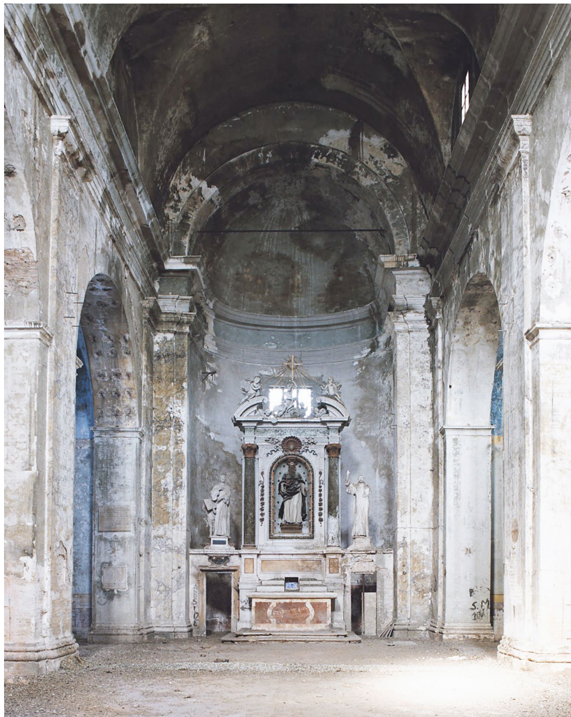
Fig. 21/ Vista dell'aula della chiesa coperta a volta a botte, con cappelle laterali e altare a diaframma.
