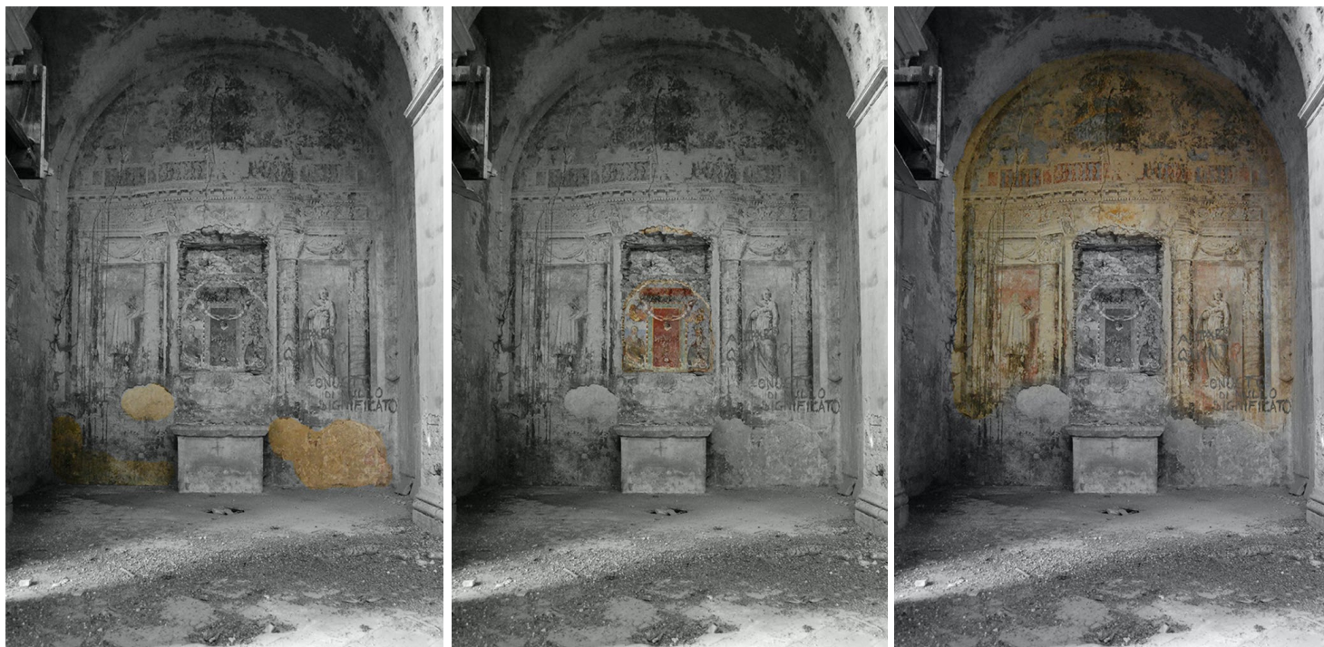
Fig. 8 La prima cappella a sinistra dell'ingresso: i fenomeni di degrado dello strato di finitura mostrano tre livelli di pitture parietali, anziché due come per le altre cappelle.
