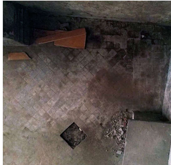
Fig. 11/ Particolari di posa in opera delle piastrelle in cotto: piastrelle disposte in fila continua dall'ingresso fino all'altare principale.
