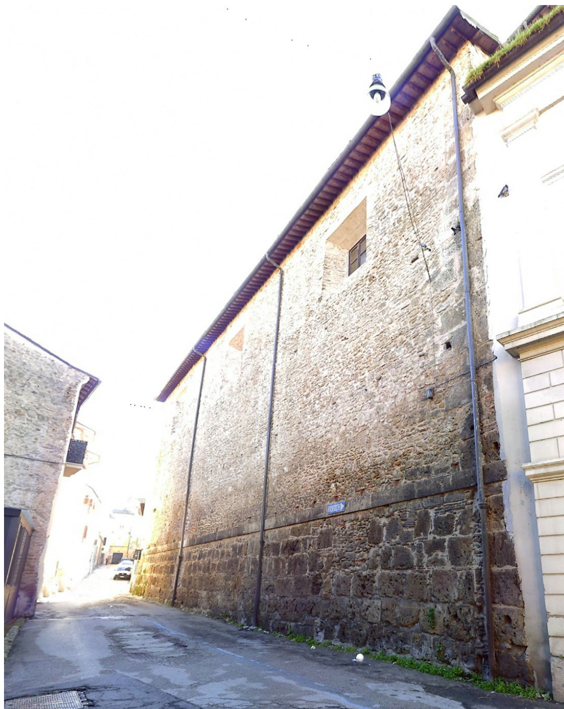
Fig. 15/ Registro inferiore del prospetto laterale, vista da via Tancredi verso l'incrocio con via del Vignola (Foto degli anni 2020-2021).
