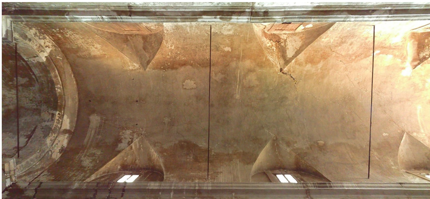
Fig. 10/ Vista dal basso della volta con lunette sferoidali. Per ognuna è presente una finestra, tamponate quelle sul lato sinistro della chiesa (in alto nella foto) per la presenza della Sala Severi.
