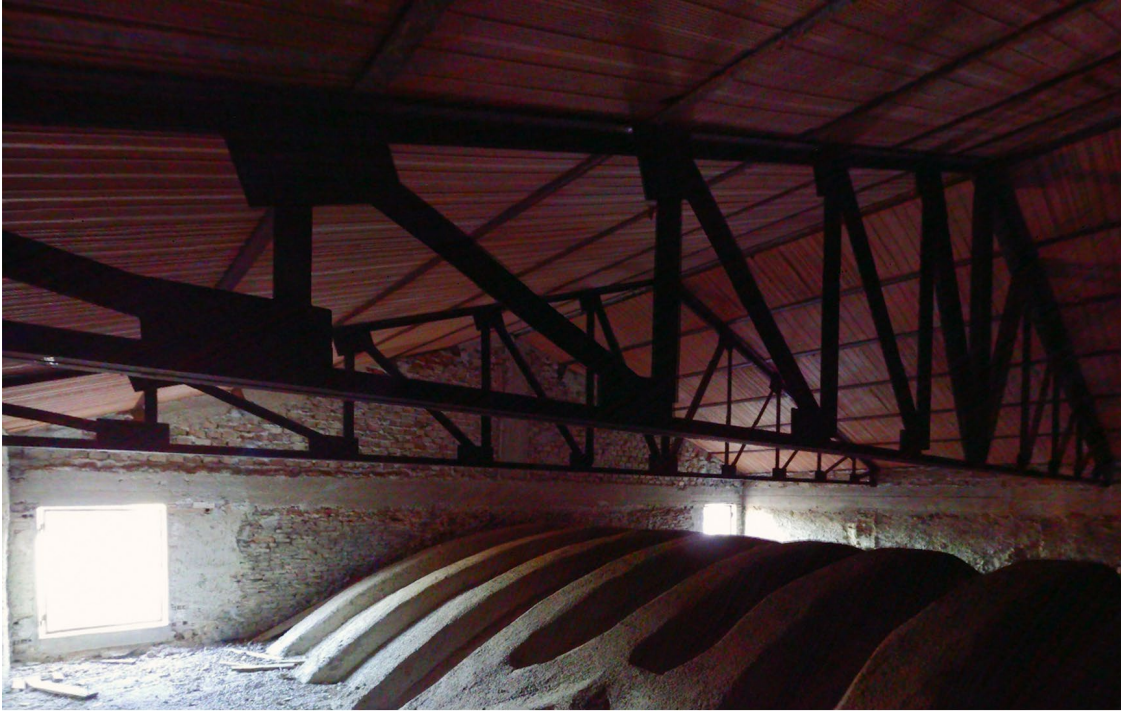
Fig. 18/ Vista dell'ambiente sottotetto dalla camera interna del laser scanner: verso la controfacciata principale è possibile notare il cordolo orizzontale e il pilastro centrale.
