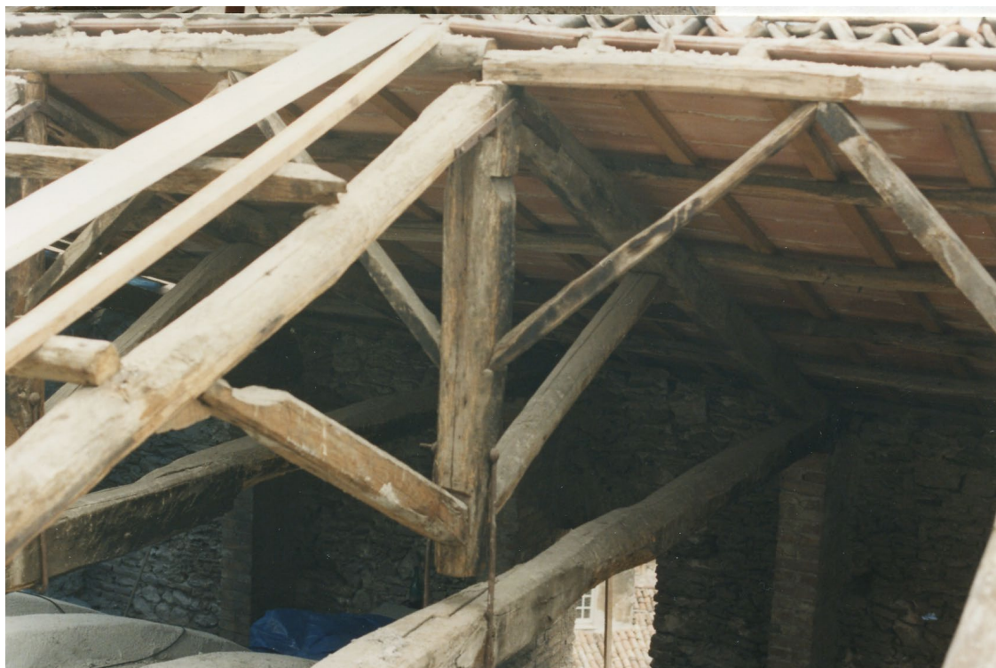
Fig. 44/ Le capriate lignee con saette fuori dal piano, prima di essere eliminate con i lavori di rifacimento della copertura (Archivio Trinchi).
