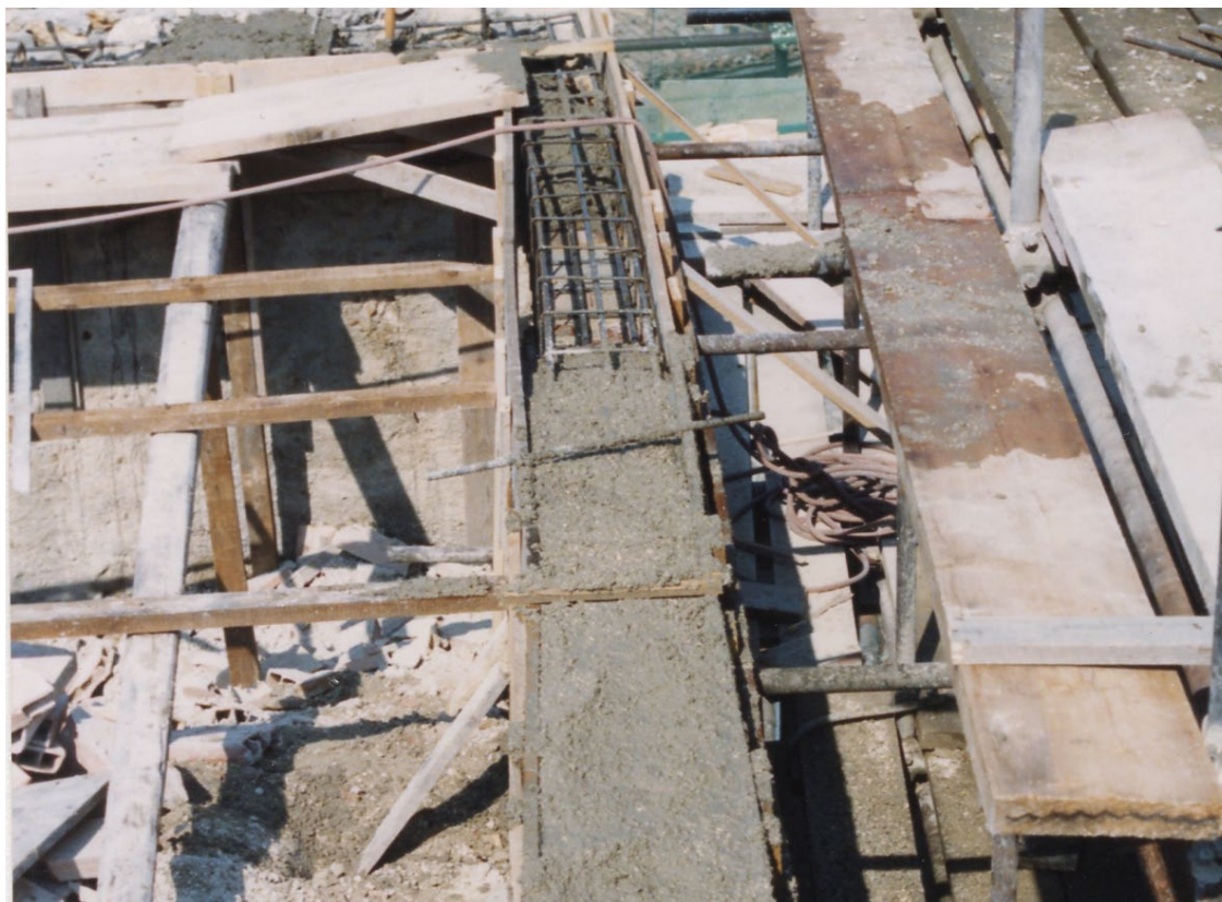
Fig. 42/ La realizzazione del cordolo in cemento armato sul muro dell'aula (Archivio Trinchi).
