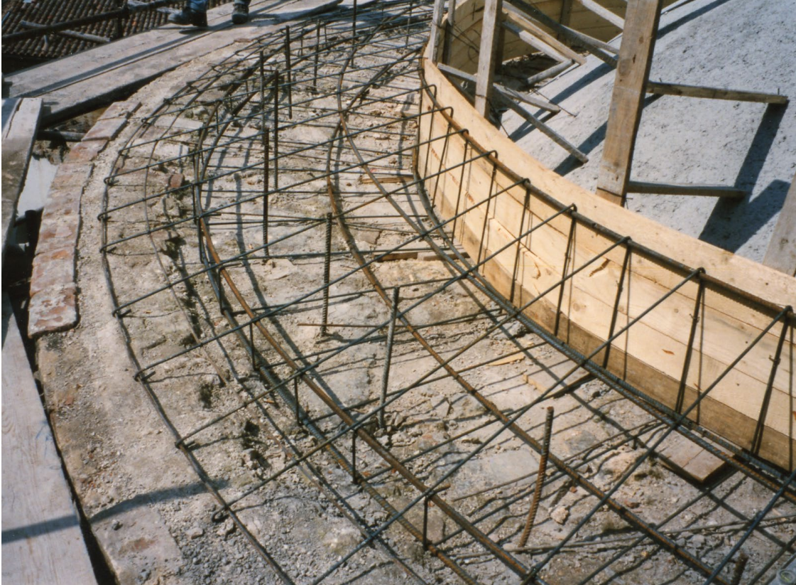
Fig. 43/ L'armatura del cordolo dell'abside (Archivio Trinchi).
