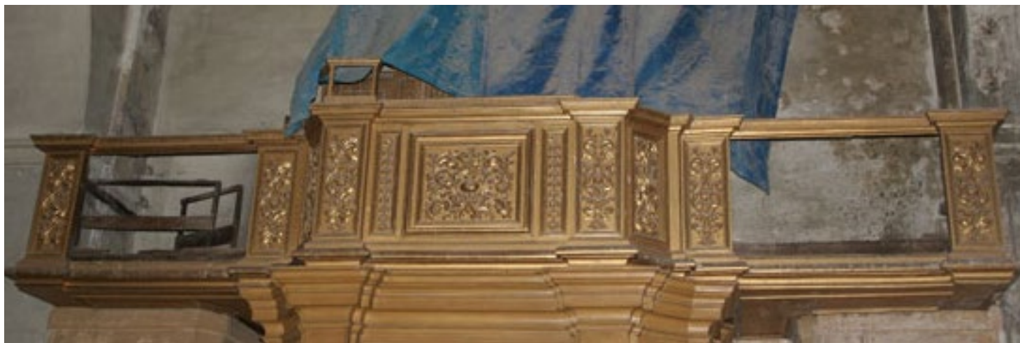
Fig. 6/ Anno 2006: balastra lignea in buono stato di conservazione ancora posizionata in loco. Foto scattata da Letizia Rosati.
