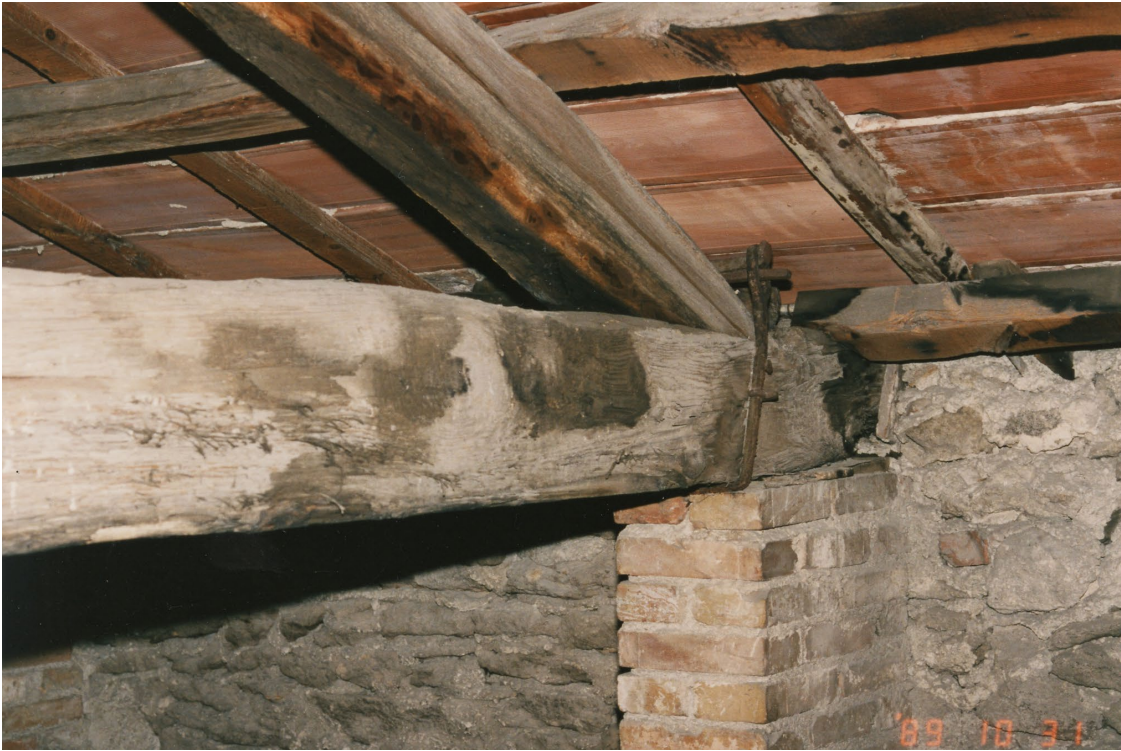
Fig. 45/ Dettagli delle vecchie capriate lignee (Archivio Trinchi).
