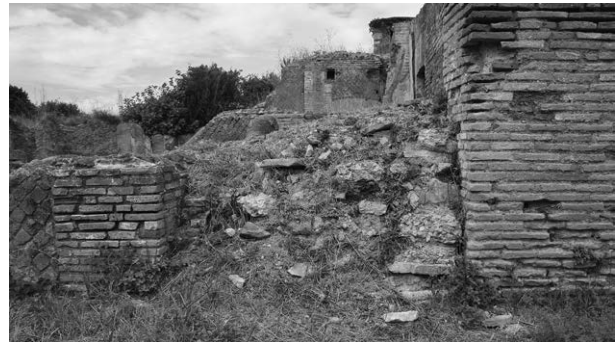
Abb. 33: Die Zusetzung der externen Treppe des Caseggiato di Bacco e Arianna
