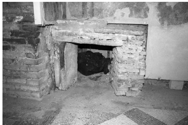
Abb. 57: Präfurnium in Korridor (i) der Domus delle Muse
