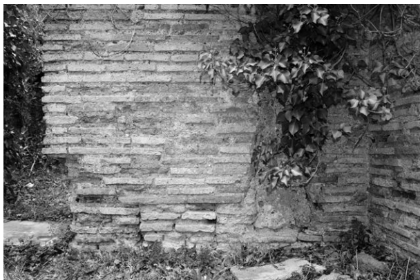
Abb. 56: Zugesetzter Heizungskanal in Raum (j) der Domus degli Augustali
