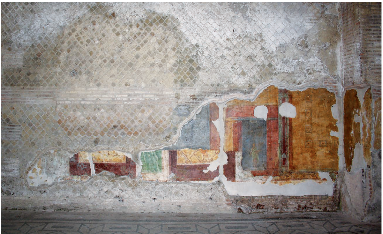
Taf. 24: Wandputz mit gemalter Marmorimitation in Raum (l) der Domus delle Muse
