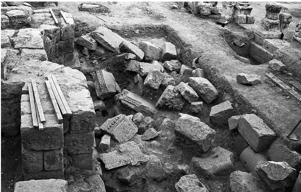
Abb. 26 Zerstörungshorizont im Wasserbecken (Areal M) zwischen den Thermen und der Pfeilerhalle: Dekorierte Gebälkblöcke, die während des Erdbebens von 749 n. Chr. in das Becken herabgestürzt waren
