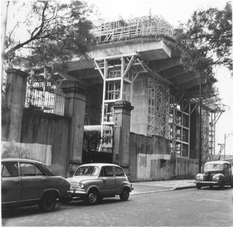
Figure 8.2 The National Library and its scaffolds (undated). Courtesy of the Biblioteca Nacional de la República Argentina, Archivos del Patrimonio Histórico del Edificio.
