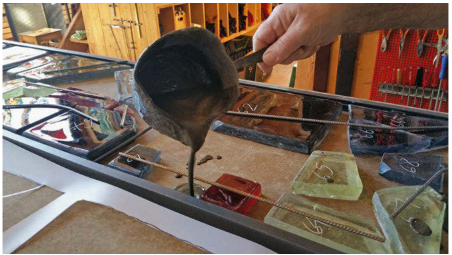
88 Coulage du béton entre les dalles de verre à l'atelier Michel Eltschinger, Villars-sur-Glâne
