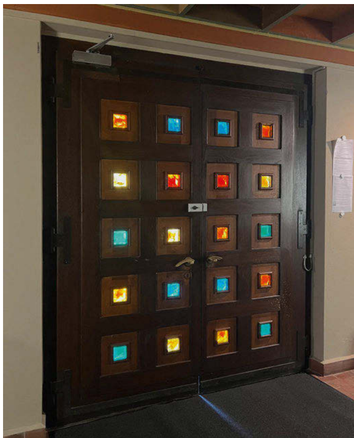
131 Porte avec insertion de carreaux en dalle de verre (maison Auguste Labouret, Paris), 1939–1941, église Saint-Pierre-aux-Liens, Mézières
