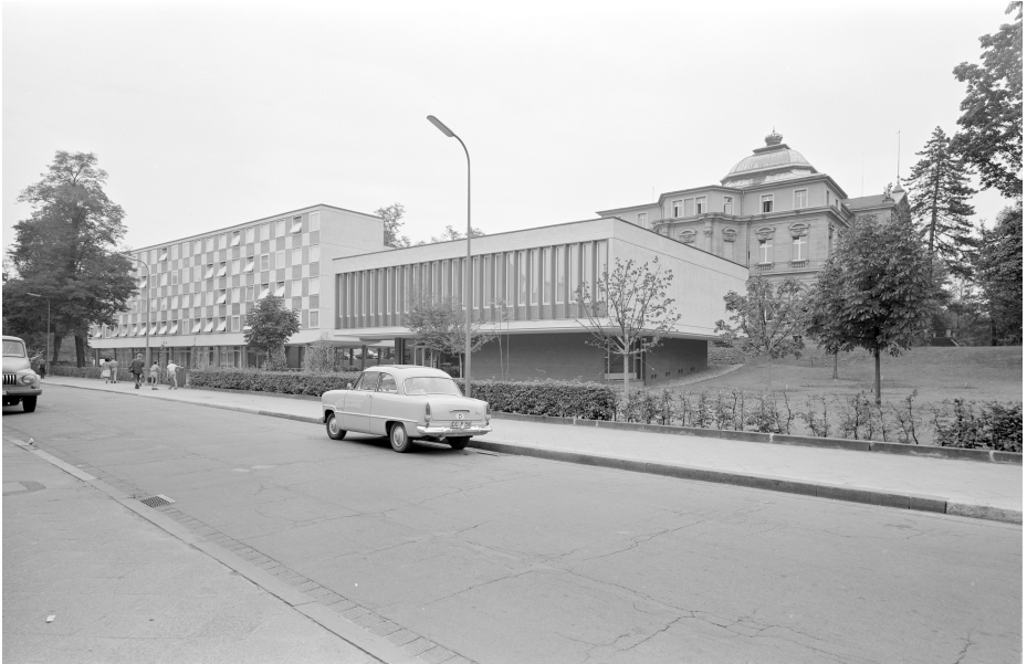
Abb. 4: Der Erweiterungsbau an der Herrenstraße Quelle: BA, B145 Bild-F011467
